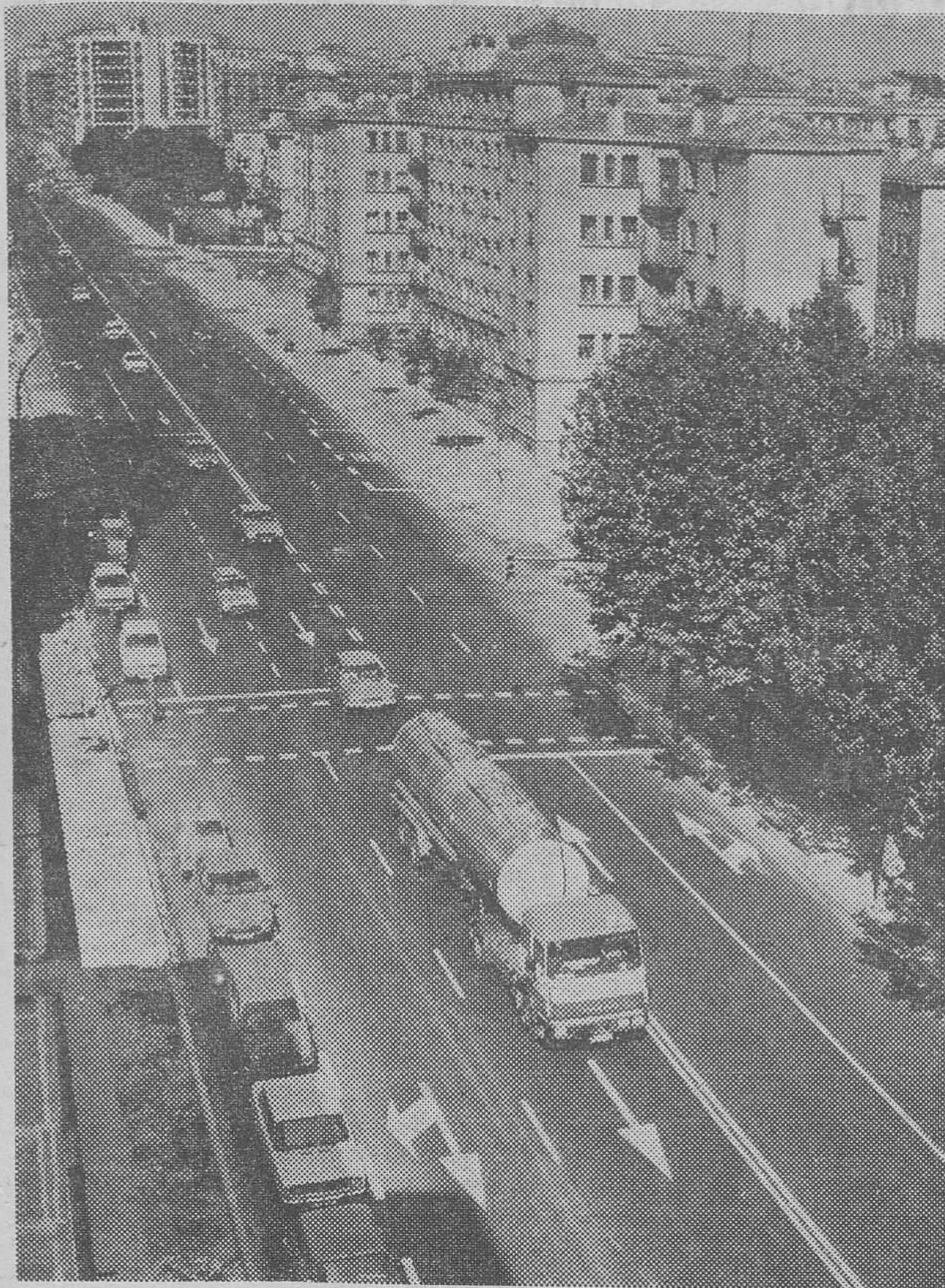
Las obras de ampliación y mejora del firme de la carretera de Madrid-Irún, desde la plaza de Logroño hasta la Academia de Ingenieros, están prácticamente en su última fase, a punto de ponerse totalmente en servicio. Cuatro carriles, dos para cada dirección y faltan las aceras y otros detalles de un proyecto que ya ha suscitado algunos comentarios por su trazado y al comienzo de la ejecución por la tala de árboles. Así ha quedado esta travesía y como testimonio la fotografía de «Fede» que ofrecemos a nuestros lectores.
