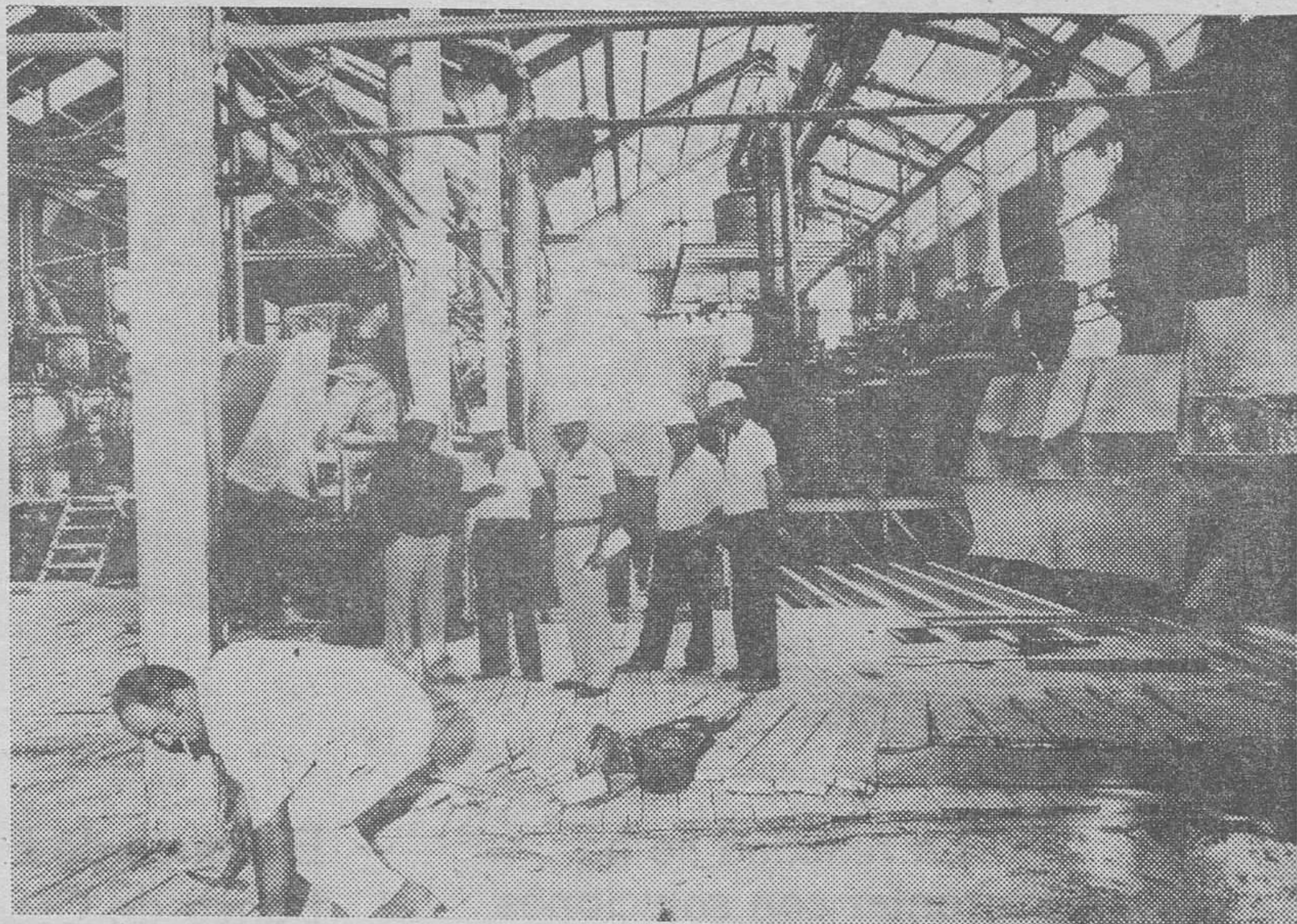
Un momento de la visita a las instalaciones de «CRIMIDESA», afectadas por el fuego. — (Foto VILAFRANCA).
