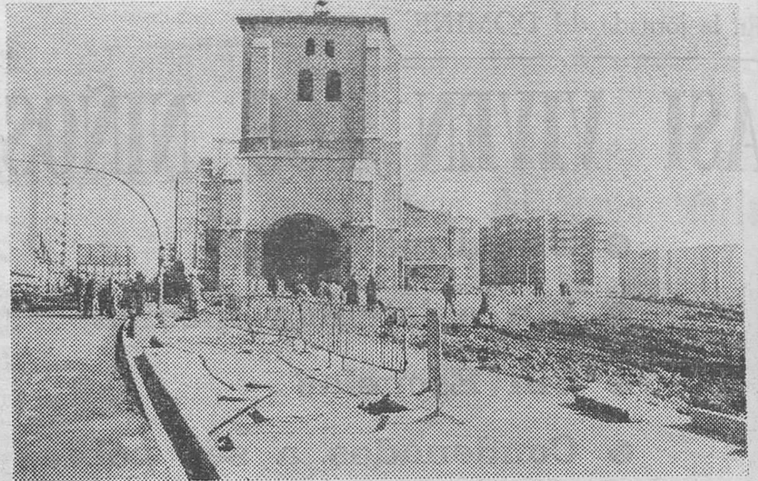
Estas son las obras de aceras en la zona de Gamonal, más próxima a la iglesia parroquial de Nuestra Señora la Real y Antigua. Con el embaldosado de estas vías se resuelve un problema importante de este populoso sector. — (Foto FEDE)
