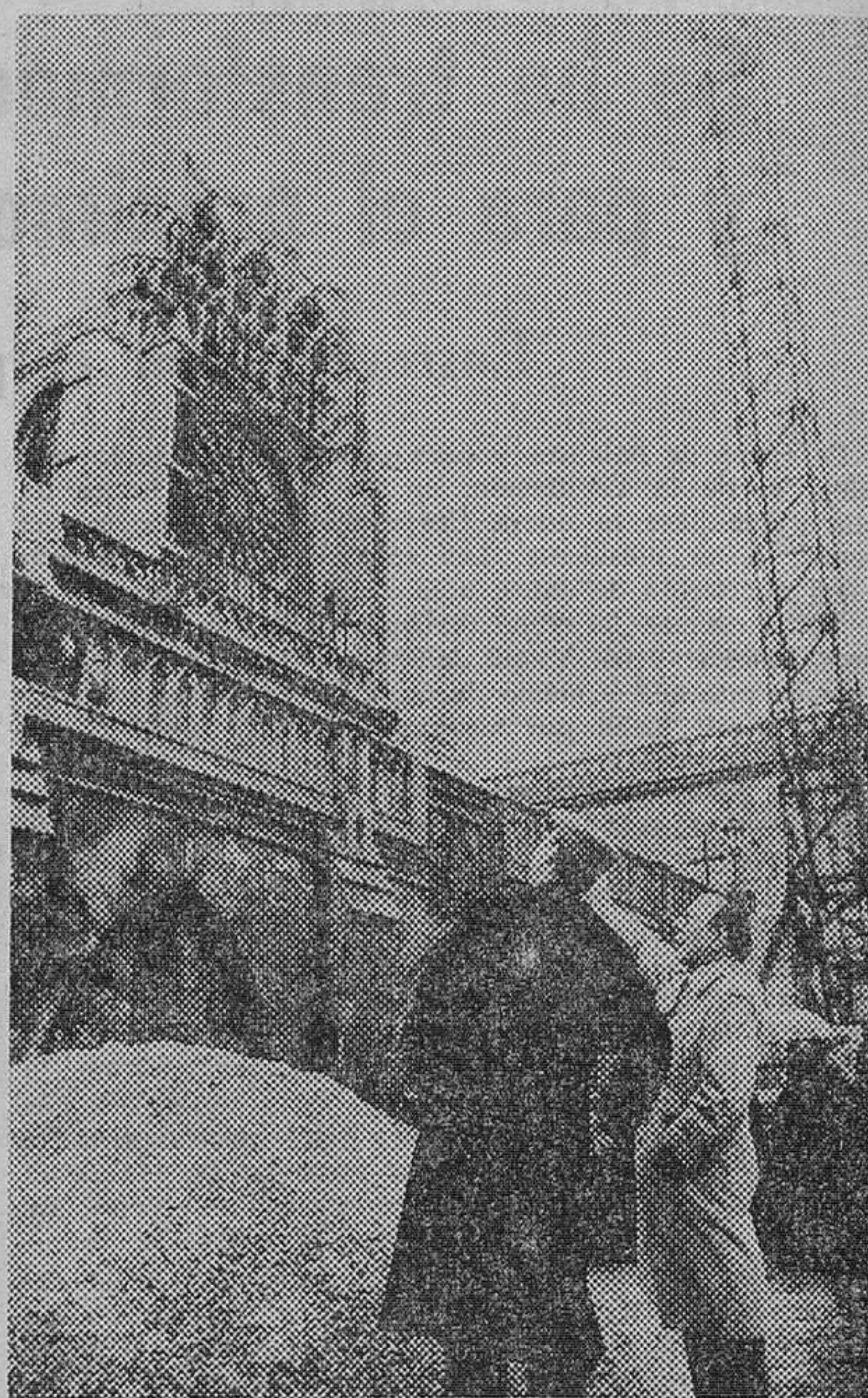
Don Marcos Rico Santamaría, explica al autor de este trabajo las obras de restauración que se efectúan en nuestra incomparable Catedral. — (Foto FEDE).
