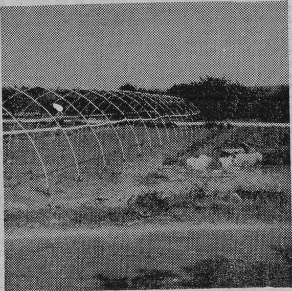
Bastidor sobre el que se extiende y sujeta el plástico.
