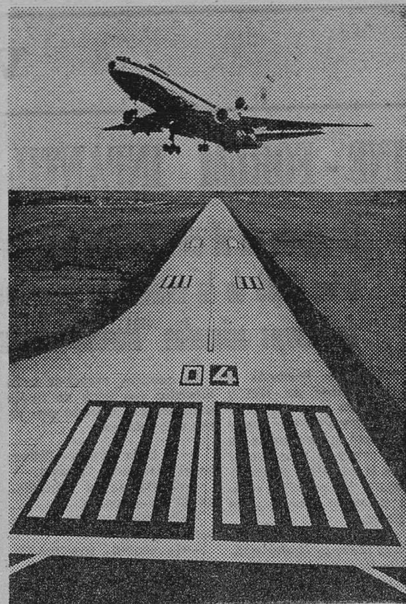
La pista de vuelo del aeropuerto de Vitoria tiene una longitud de 3.500 metros y una anchura de 45 metros.
