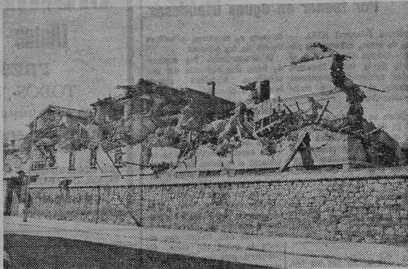
A gran ritmo se han iniciado los trabajos de derribo del centenario inmueble del Asilo de los Ancianos Desamparados, y con ayuda de una moderna grúa de brazo hidráulico ya ha sido demolida parte de la construcción.
