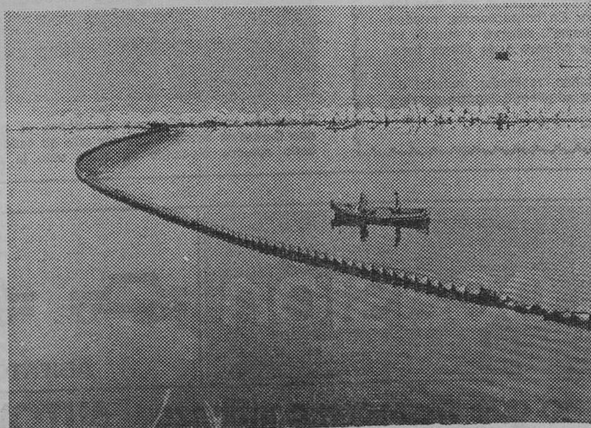
Esta ingeniosa cadena de latas, instalada en el canal de La Mede-Martigues (en la desembocadura del río Ródano), forma una eficiente barrera para contener el petróleo que inevitablemente se pierde al ser descargado en el puerto de La Mede. (Foto FIEL-KEYSTONE)
