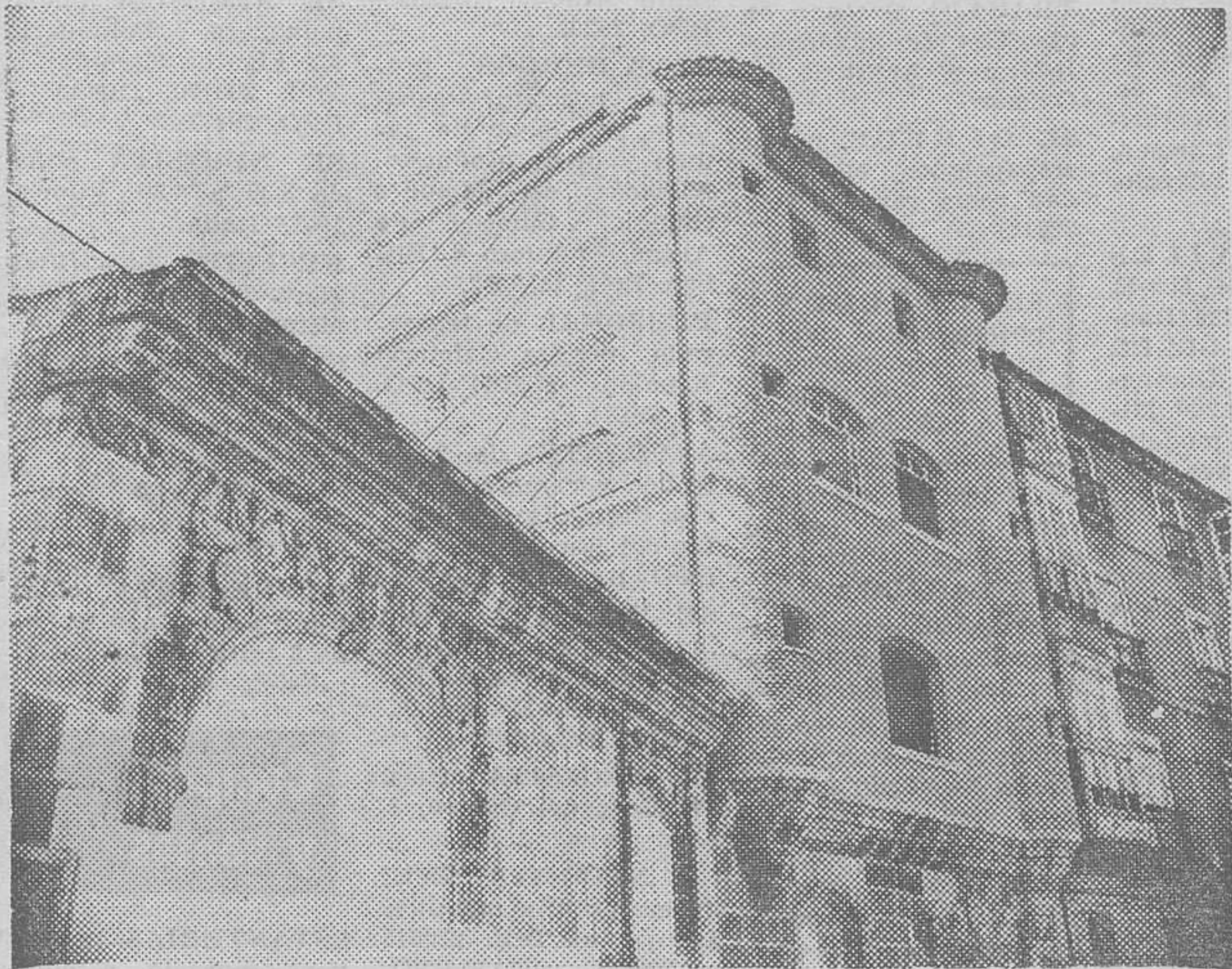
La histórica "Casa del Cubo" en la calle Fernán González supervive en una admirable solución arquitectónica, gracias al Colegio oficial de Arquitectos que, respetando el solar y los elementos dignos de conservarse, está construyendo un nuevo edificio reconstruyendo el diseño original. — (Foto FEDE).
