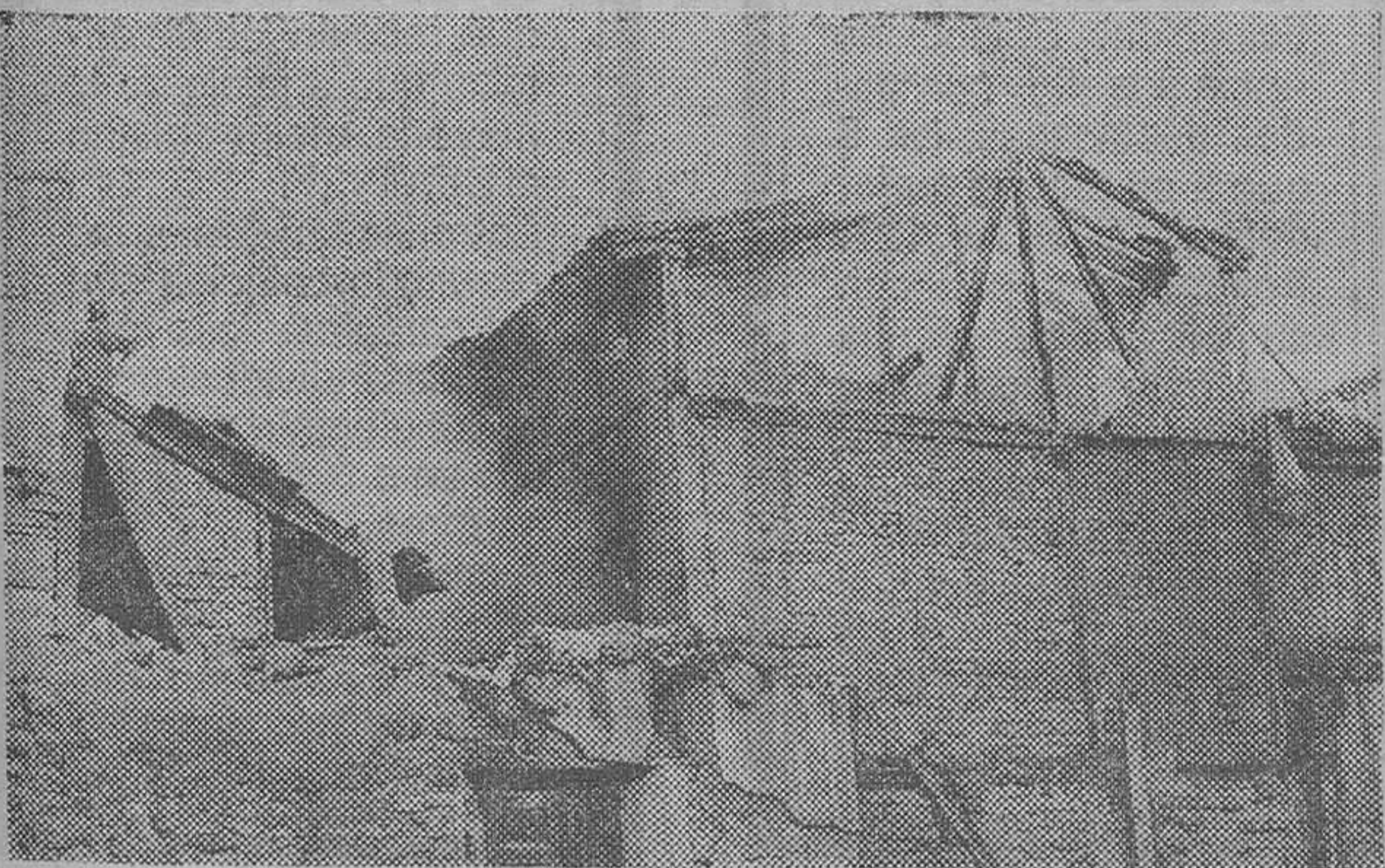
Un aspecto del incendio producido en la tarde del domingo, en Aranda de Duero (Foto Reyes)
