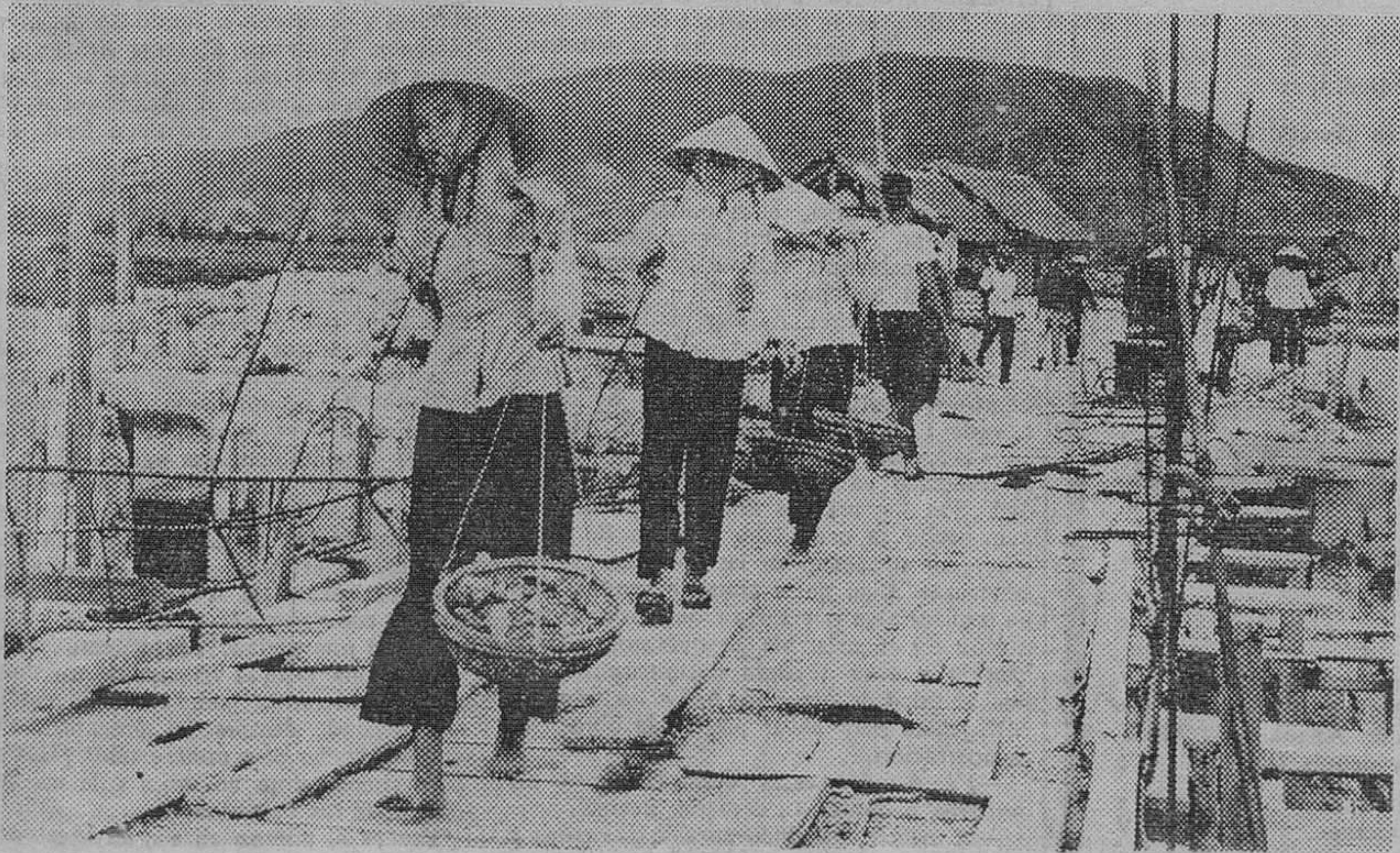
Continúan los trabajos para la reconstrucción de tantos y tantos daños causados por la guerra en Vietnam. Las mujeres de las cooperativas agrícolas cercanas a la presa de Song Kha, en la provincia de Nghe An colaboran también en la tarea incluso realizando los más duros trabajos. Cuando la presa esté terminada, en 1975, un canal de 35 kilómetros llevará agua suficiente para regar 18.000 hectáreas de arrozales en Vinh. Desde 1968 hasta 1972 esta presa fue bombardeada numerosas veces. En esta foto vemos una muestra de los trabajos que en ella realizan las mujeres (Foto FIEL)
