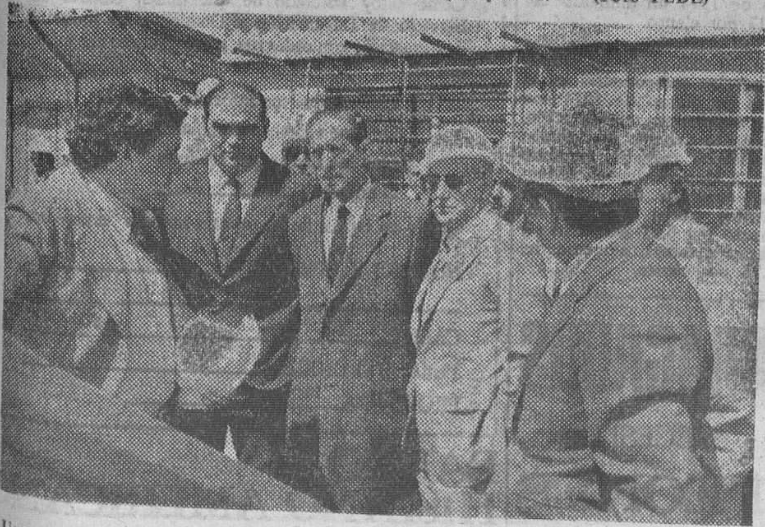
Un momento de la visita efectuada a las obras de la nueva planta en el Polígono de Gamonal. — (Foto FEDE)
