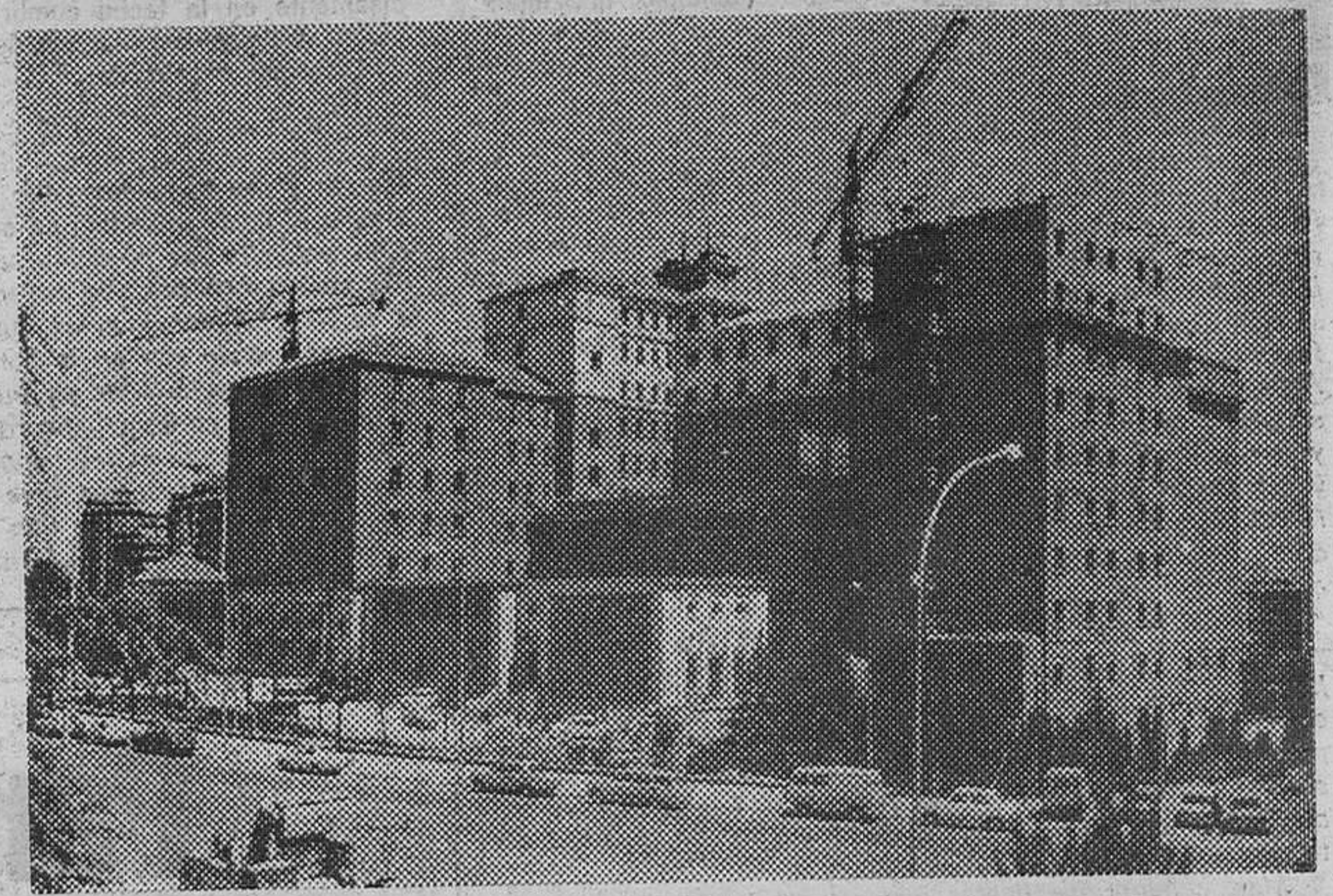
Otro aspecto de la Residencia, en el curso de las obras.
