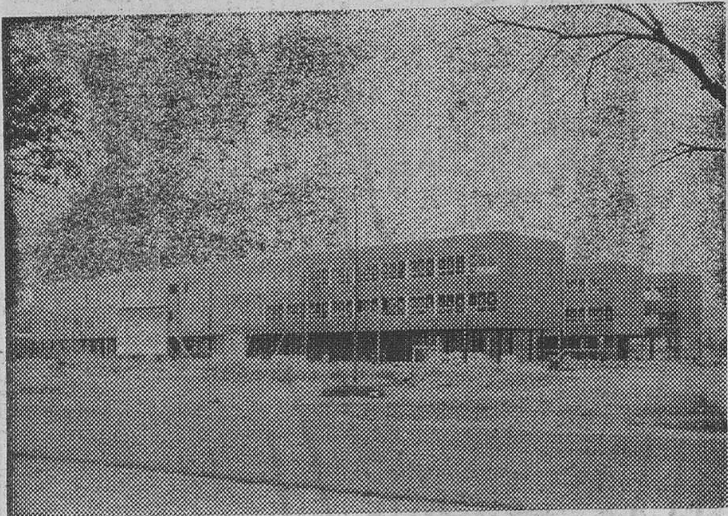
Los edificios del C.U.A., en trance de conclusión.
