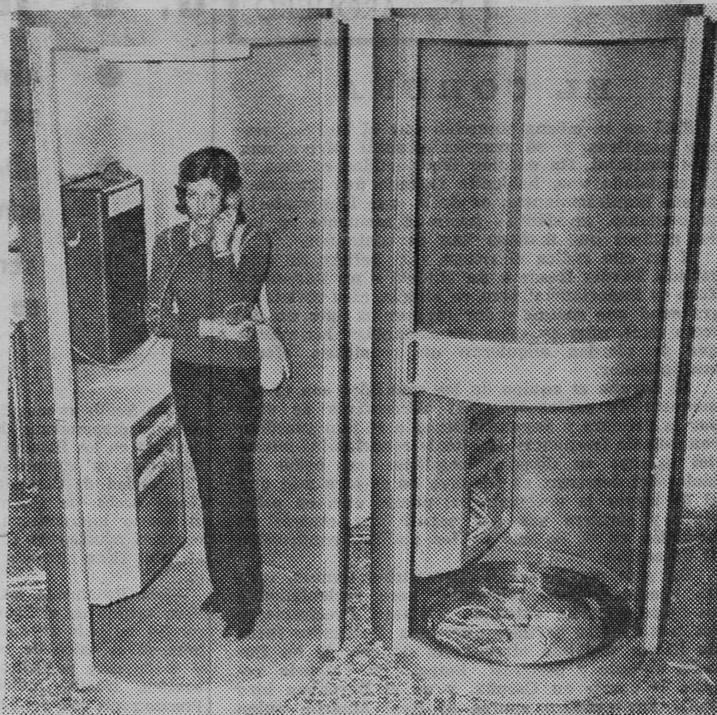
El Servicio de Correos y Comunicaciones de la República Federal de Alemania instalará este nuevo tipo de cabinas telefónicas en los terrenos de la Olimpiada de Munich. Han sido especialmente diseñadas para ella. Miden dos metros de altura y son de acero y aluminio. El suelo está cubierto por una tela a prueba de incendios y el lugar para las guías telefónicas puede emplearse también como pupitre. Las puertas, de vidrio de alta seguridad, son redondas y giratorias. — (Foto Fiel)
