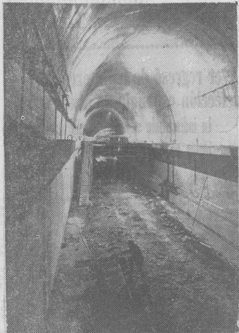
Wuppertal. — Esta bóveda representa quizás la obra más interesante de Europa. En Wuppertal se está construyendo el primer túnel de dos pisos de Europa que, en una longitud de 855 metros, atraviesa un monte de tierra arenosa. La foto muestra las dos trazas de la circulación en una sola dirección. La ventilación será proporcionada ampliamente por el remolino producido por la corriente de vehículos. — (Foto DAD)
