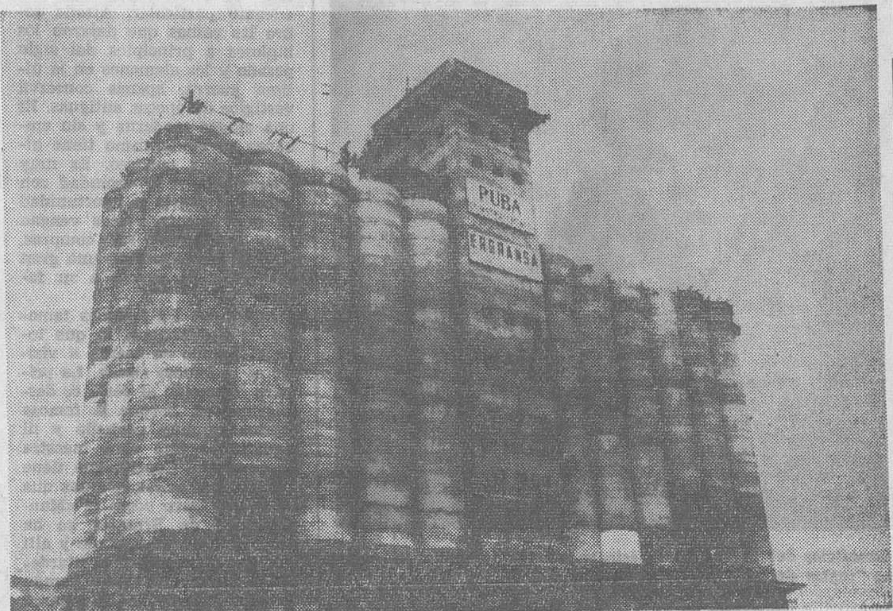
Uno de los modernos silos en construcción de nuestra red nacional. — (Foto Cifra)
