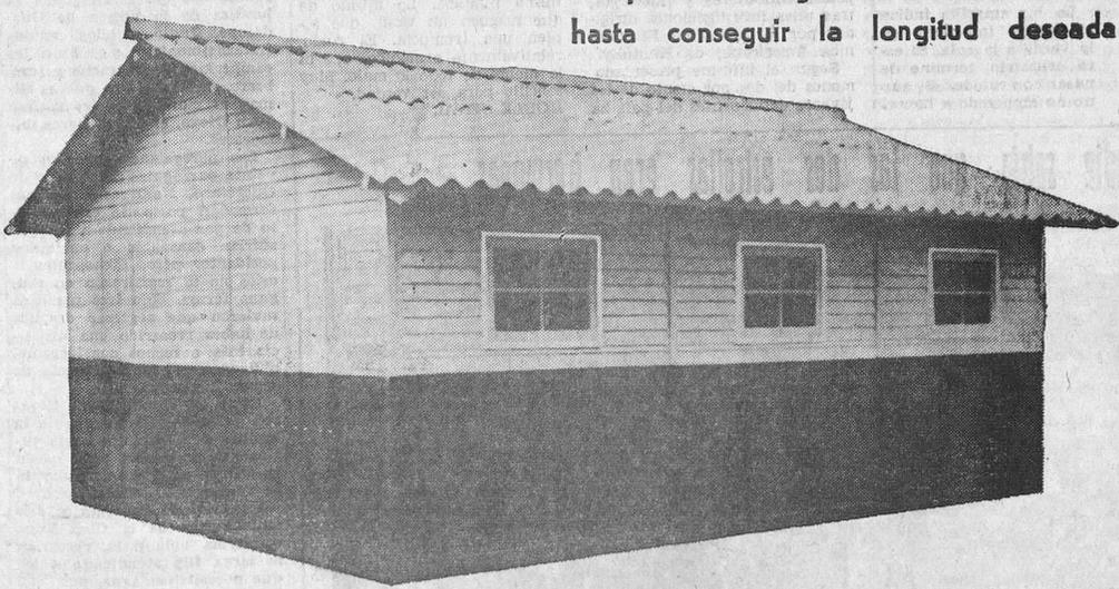
Los barracones prefabricados "CALVO", se arman con toda rapidez, y su despiece en medidas adecuadas facilita su transporte. Los barracones prefabricados "CALVO" evitan la construcción provisional de obras de ladrillo que, al ser luego destruidas, producen pérdidas de material y mano de obra.
