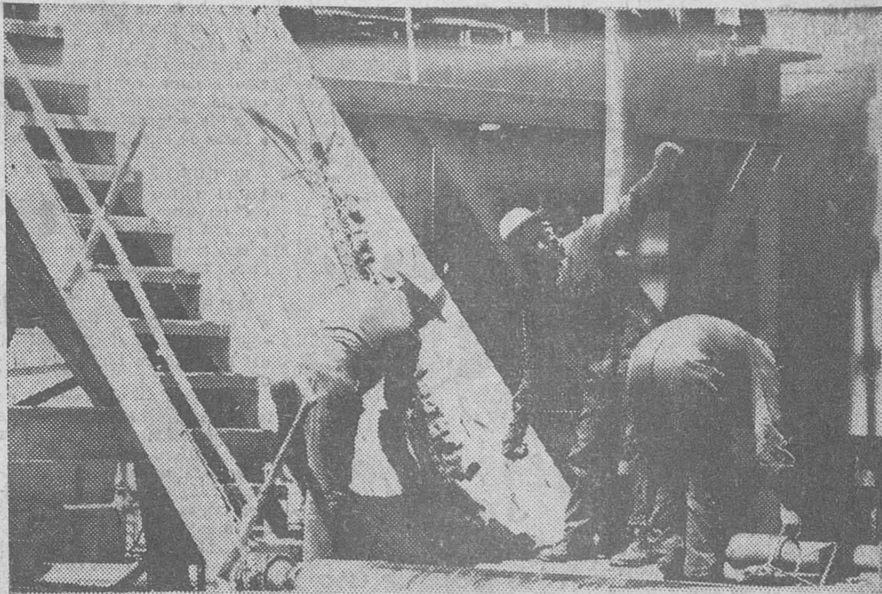
La difícil manipulación del «log», uno de los que se emplean para recoger las muestras de las estructuras de capas inferiores en la zona del yacimiento petrolífero, a efectos de los correspondientes análisis. —(Foto FEDE).
