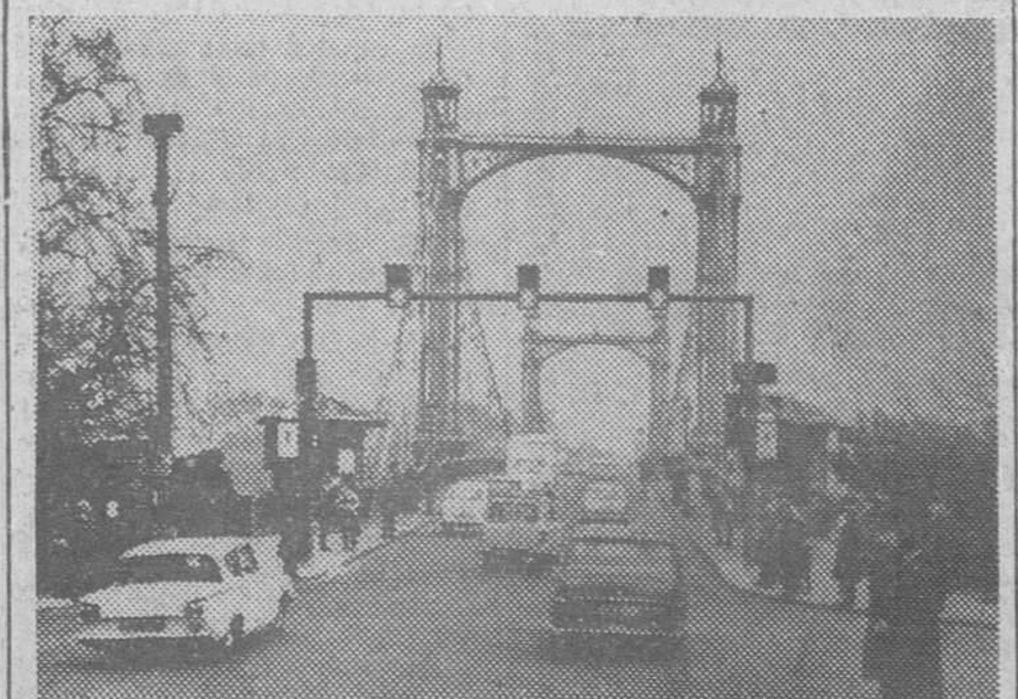
Londres. — Las autoridades británicas de tráfico han puesto en práctica una nueva idea para facilitar el cruce sobre el río Támesis, a través del Albert Bridge, en Chelsea. Por la mañana sólo se puede circular por él en sentido Norte. Por la tarde, sólo en sentido Sur. Inauguró el nuevo sistema el ministro de Transportes, Mr. Ernest Marples. — (Foto Cifra)
