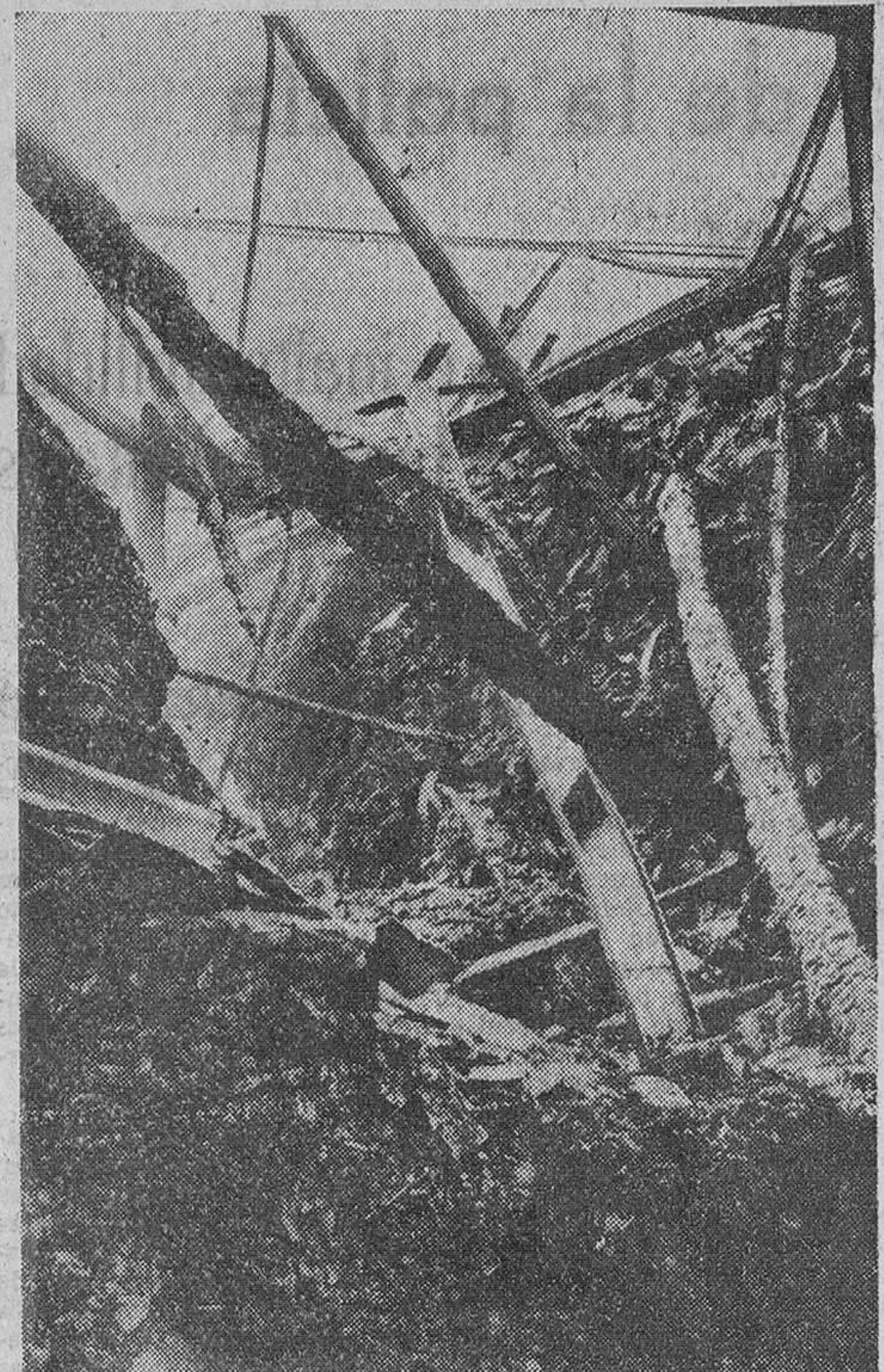
Nuestro fotógrafo, «Fede», captó ayer este desolador aspecto de hierros retorcidos y vigas y sacos calcinados, que presentaba la nave que fue pasto de las llamas, en la «Azucarera del Arlanzón».
