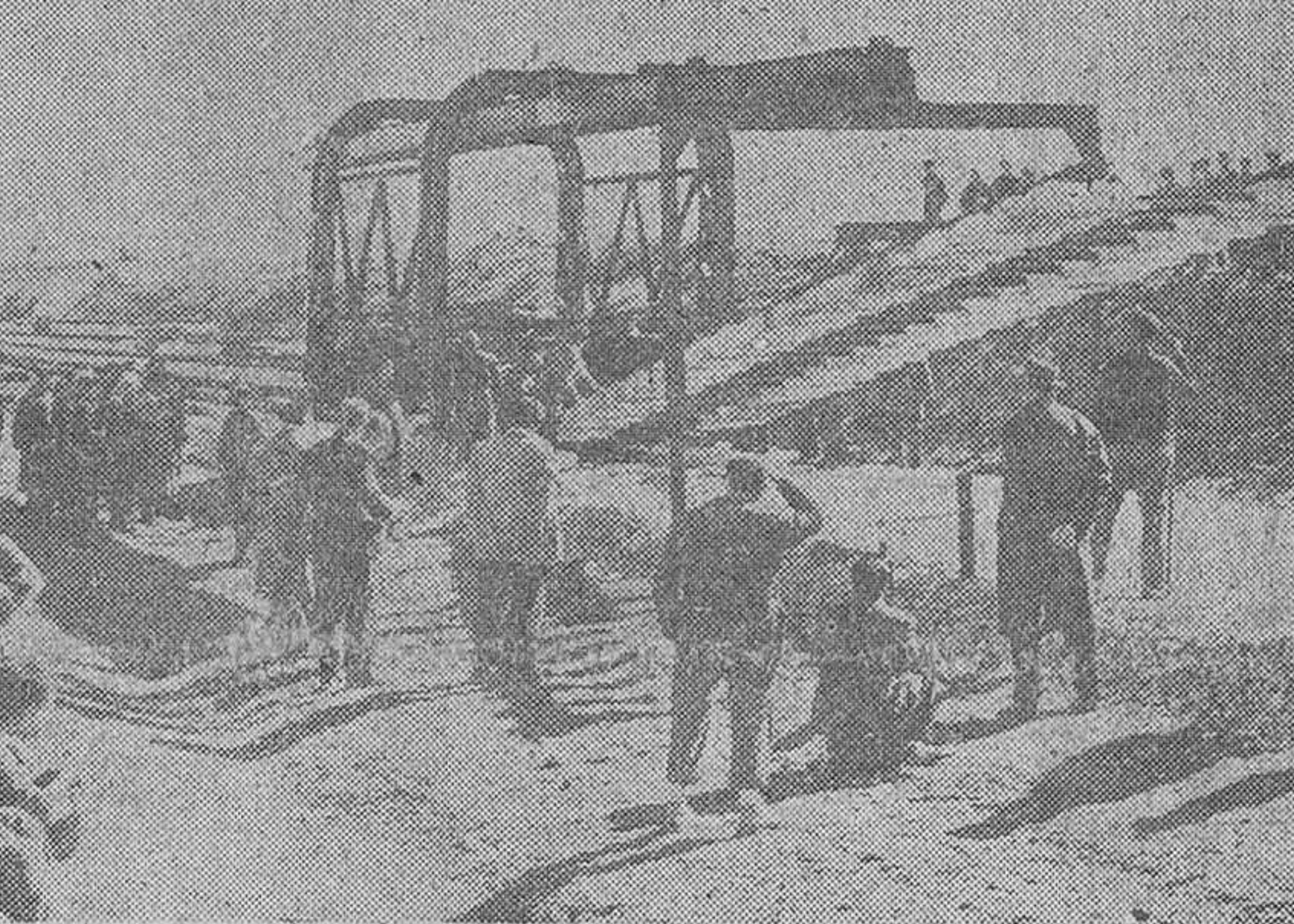
El director general de Ferrocarriles conversando con el gobernador civil acerca de determinadas características técnicas del Madrid-Burgos, en el trayecto visitado ayer. — Al pie, momento de la colocación de carriles en Villagonzalo Pedernales, como quien dice a la entrada de la ciudad. Foto FEDE
