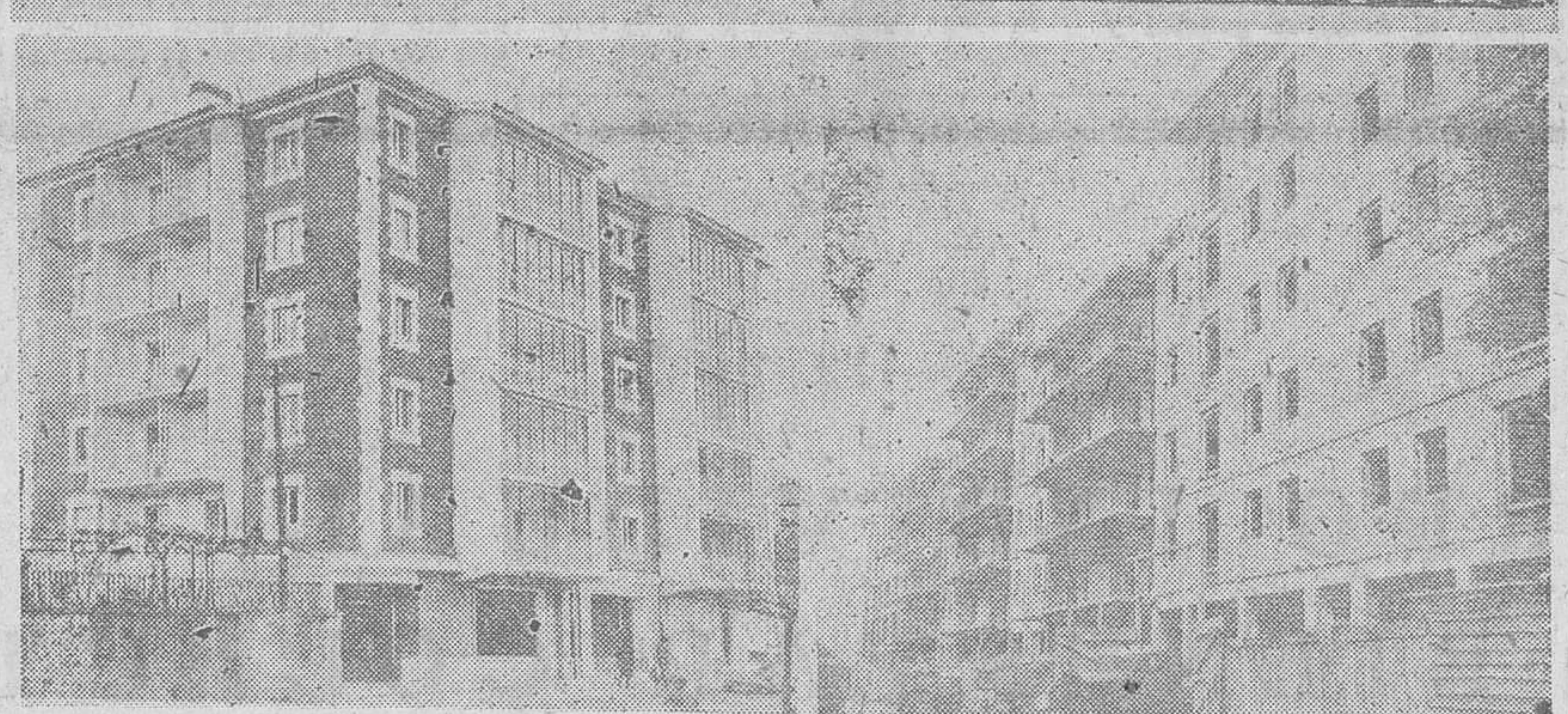
EN LA PARTE SUPERIOR DEL ZABADO SE RECOGEN DOS ASPECTOS DEL PROYECTO DE EDIFICIO QUE SE CONSTRUYE EN LA ZONA DEL MORCO. A DERECHA, LAS MAS RECIENTES VIVIENDAS DE LA ZONA DE ZATORRE
