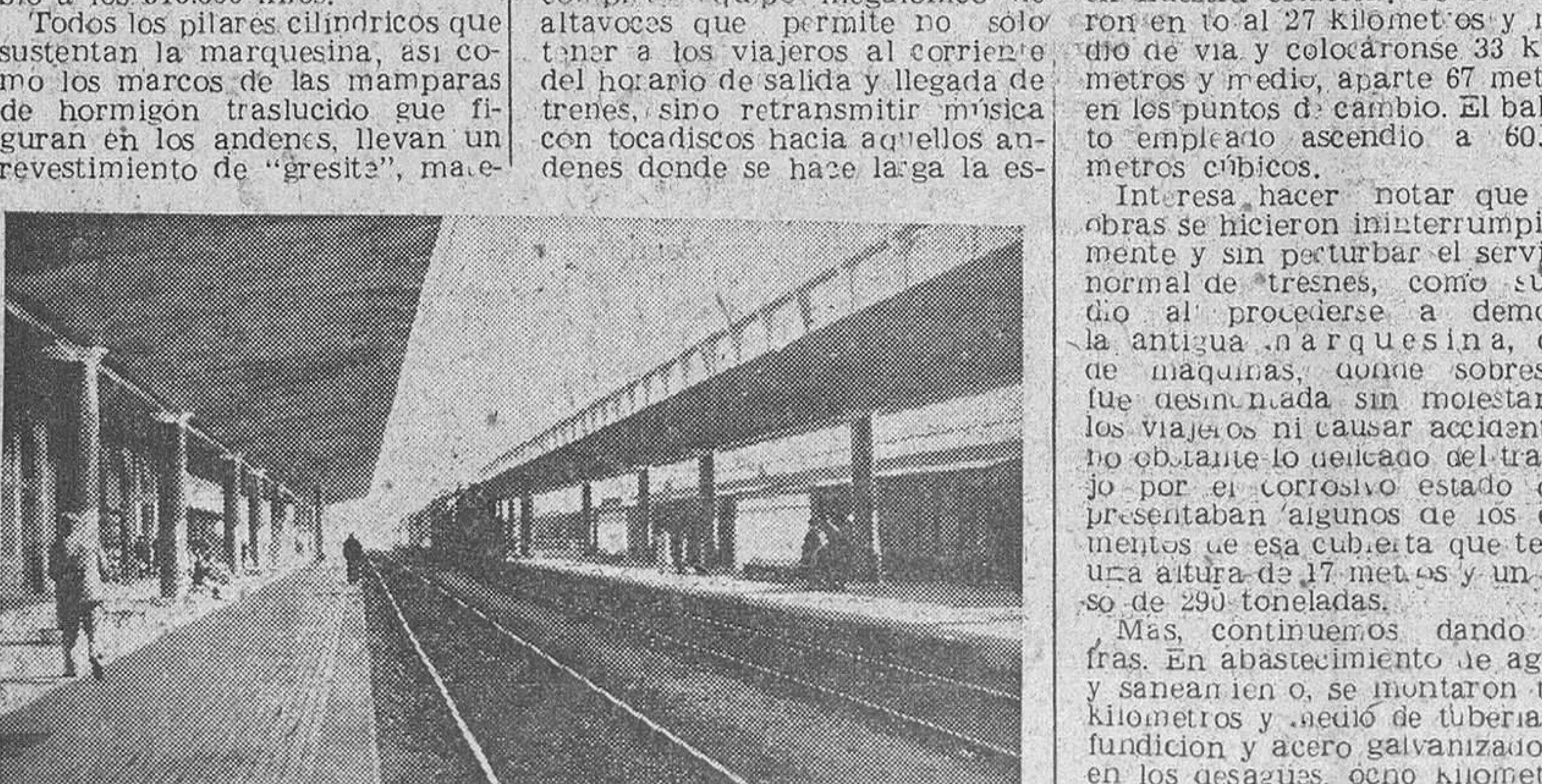
Otro aspecto de la nueva «Estación común», de Burgos, en que se aprecia su perfecta visibilidad y el desahogo con que los trenes pueden realizar sus entradas y maniobra...
