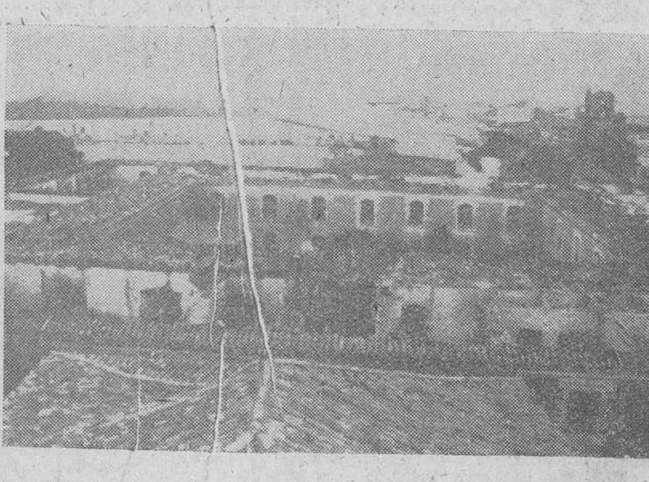
Valladolid.—Fotografía del Monasterio de Vega, actual convento de las Reverendas Madres Benedictinas, después del voraz incendio que destruyó completamente el inmueble.—(Foto Cifra)
