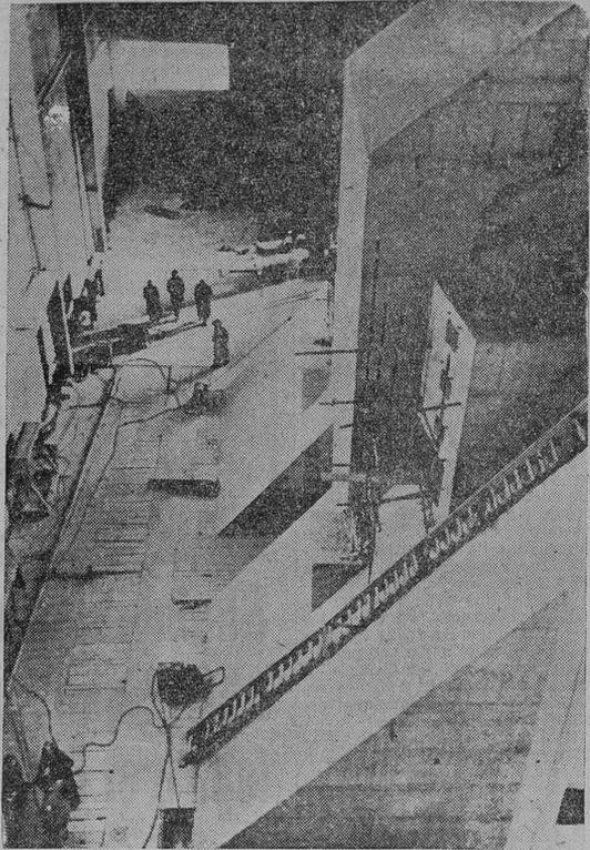
He aquí la parte oeste de la pila 0-1 de Marcoule, que producirá 15 kilogramos de plutonio por año. Puede apreciarse la grandiosa protección de hormigón. — (Foto Gil del del Espinar)
