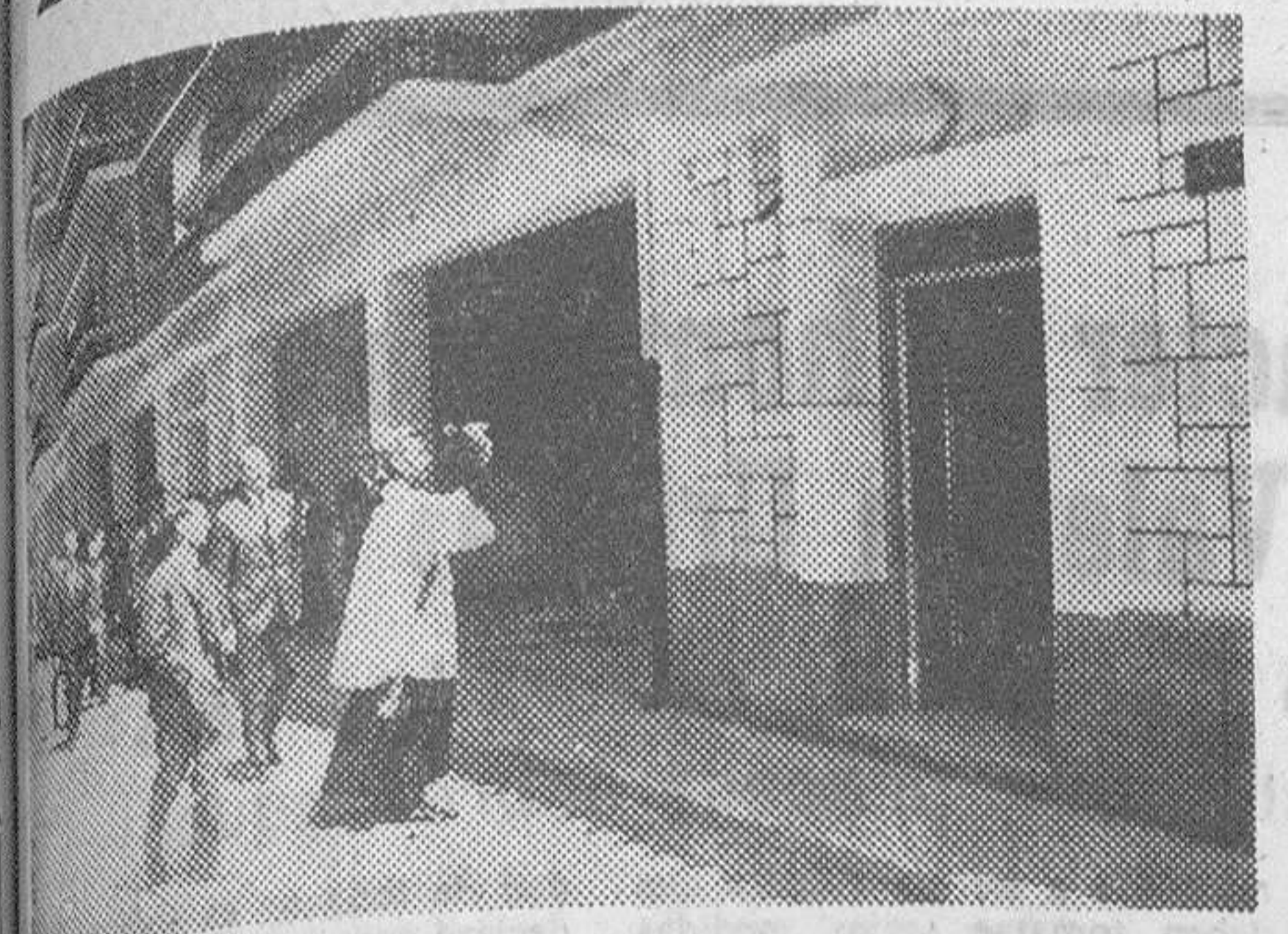
Momento de la bendición por el arcipreste, Rvdo. D. Modesto Gómez, del edificio destinado a Parque de Bomberos de Aranda de Duero, que tuvo lugar el día 7 de Agosto.—(F. Díaz)
