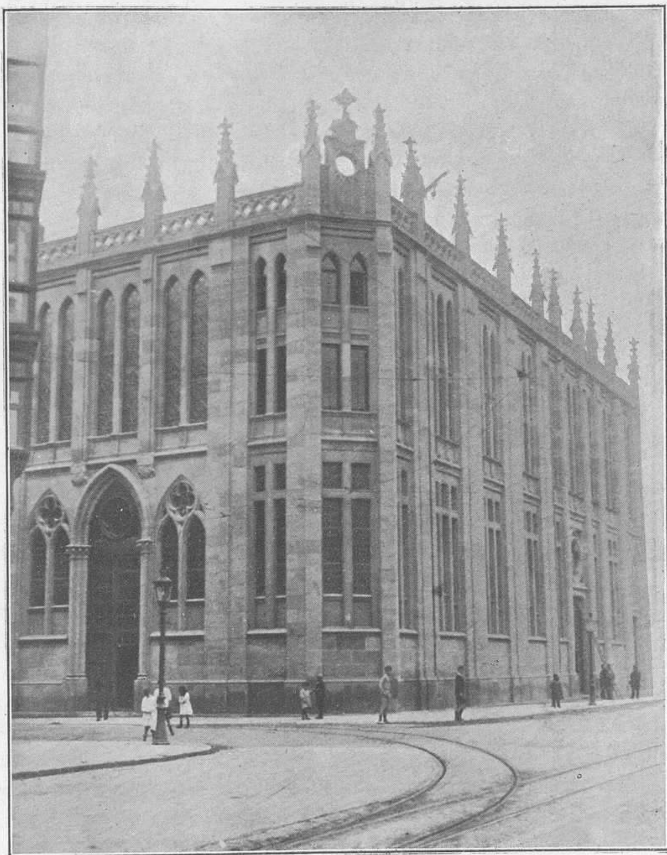
NUEVA IGLESIA Y CONVENTO DE LOS PP. CARMELITAS DE SAN SEBASTIÁN
