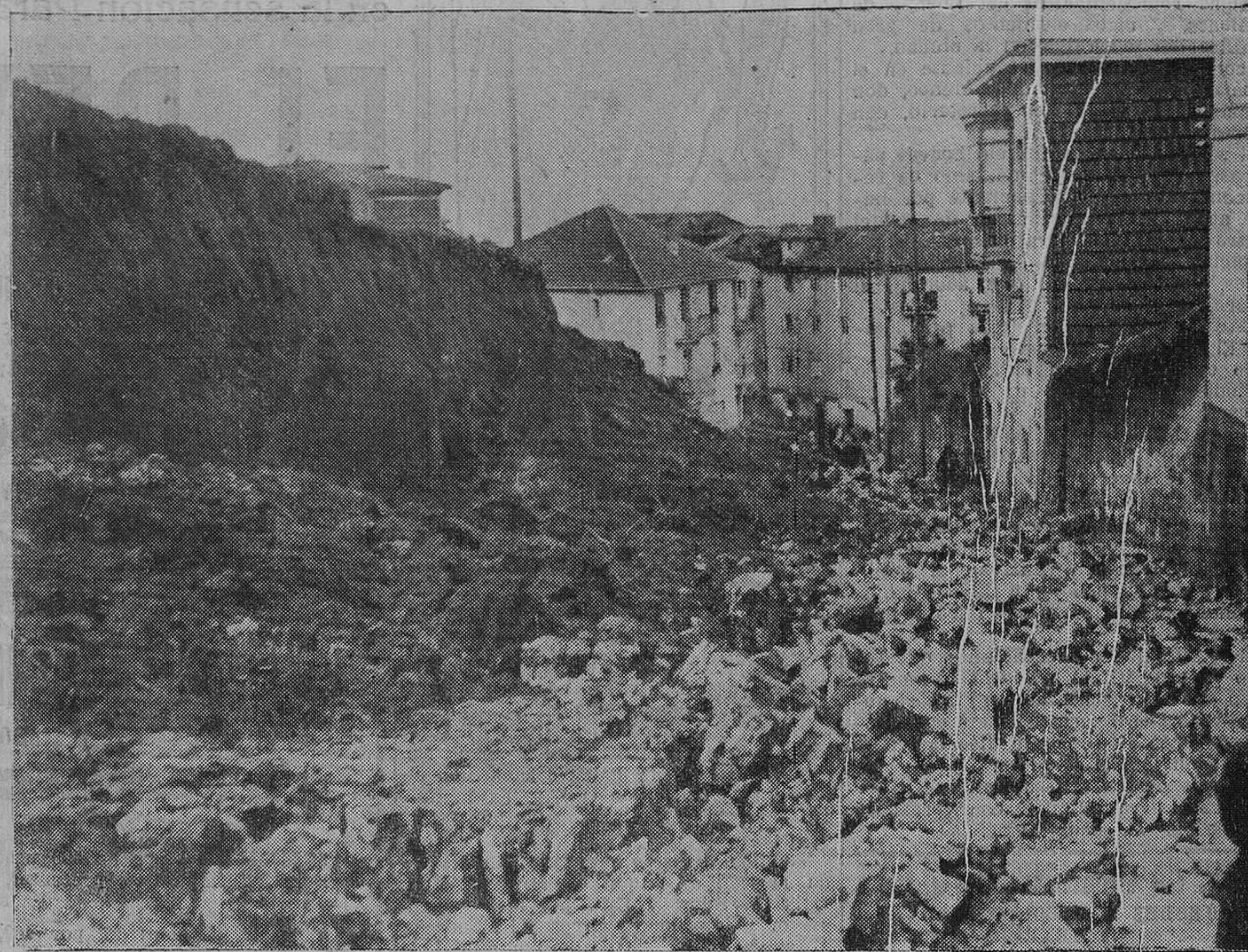
DE UN DERRUMBAMIENTO. — Estado en que quedó la cuesta de la Atalaya después del importante derrumbamiento en la tarde del lunes, y que arrastró cuatrocientos metros cúbicos de tierra. (Foto Samot.)
