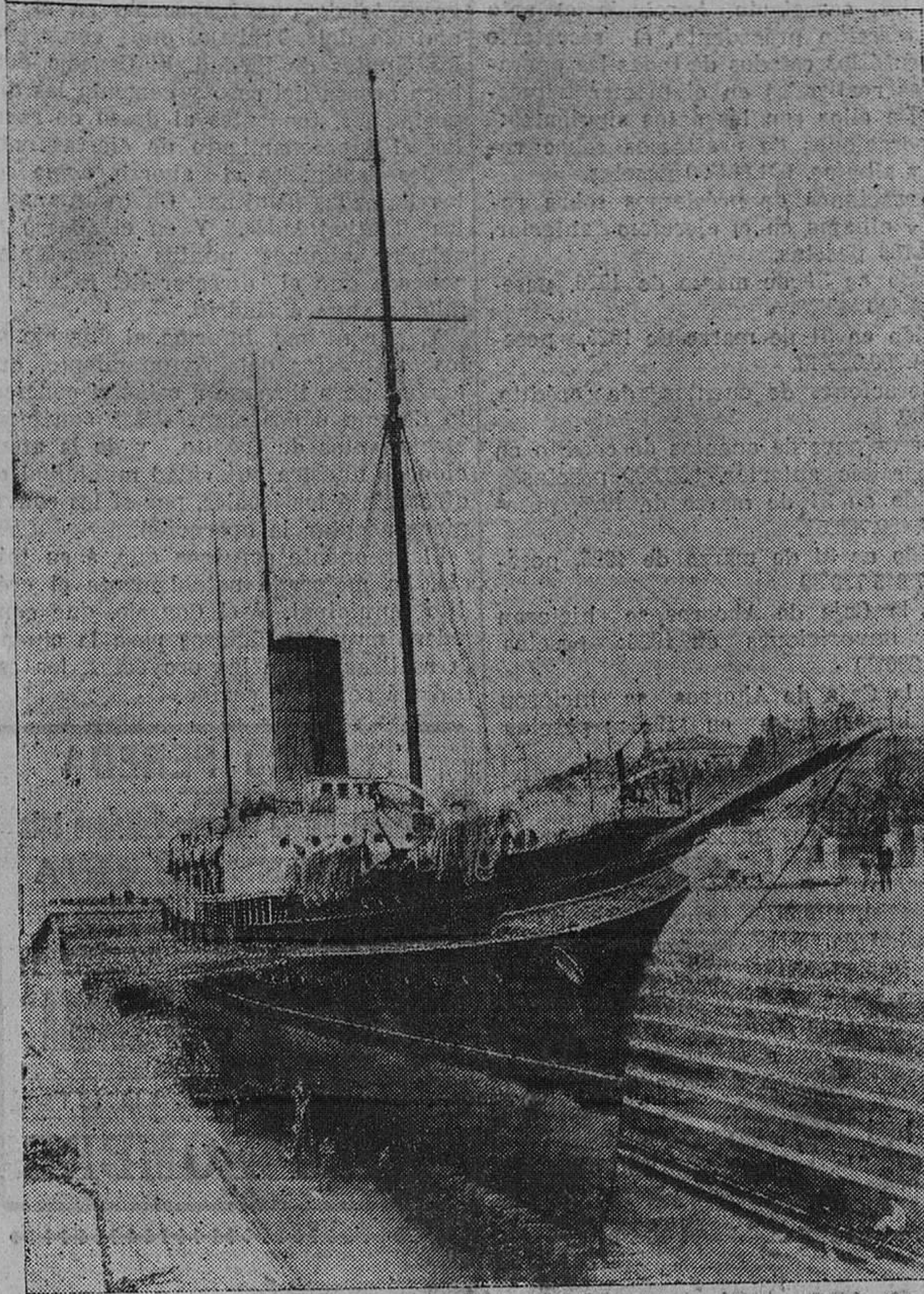
El buque, planero "Giraldá", de la Armada española, que ha entrado en el dique de Gamazo para reparación y para limpieza de fondos.
