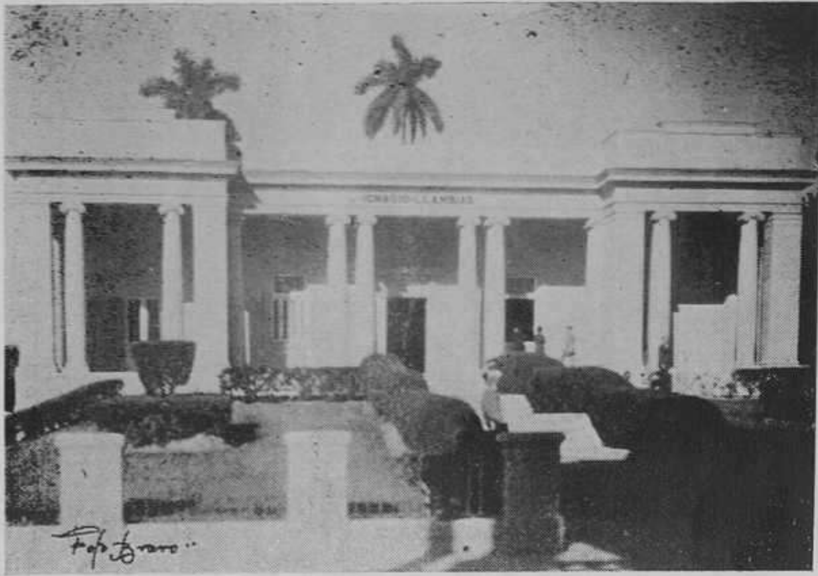
PABELLON DE RADIOGRAFIA, "Ignacio Llamblas". —Construido, siendo Avelino González presidente. En este Pabellón se encuentran instalados los aparatos más modernos y valiosos que la ciencia médica recomienda. La magnífica labor social de Avelino González cuenta en su haber con esta grandeza de la Quinta "La Purísima Concepción", orgullo de propios y admiración de extraños. Hay que defender este patrimonio. (Comité pro Candidatura GANCEDO-SOLAUN).
