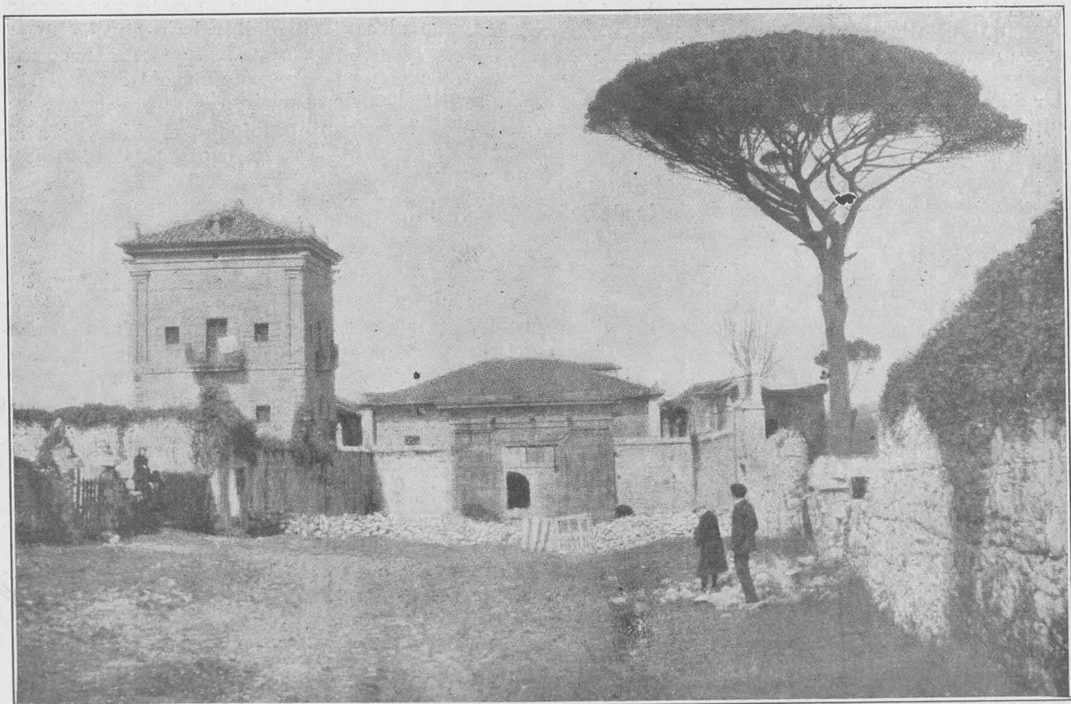
Casa solariega fundada en Muriedas (Santander) por el abuelo de Dcn Pedro Velarde, en la que hasta hace poco creíase que había nacido el héroe, siendo lo cierto que la casa donde vió la luz, se encuentra a pocos pasos de ésta. La equivocación se originó por la frase que dijo Isabel II en su visita a Muriedas el año 1861 "Muy alta está tu copa, pero más alta está tu gloria" al contemplar el pino que plantó Velarde.
