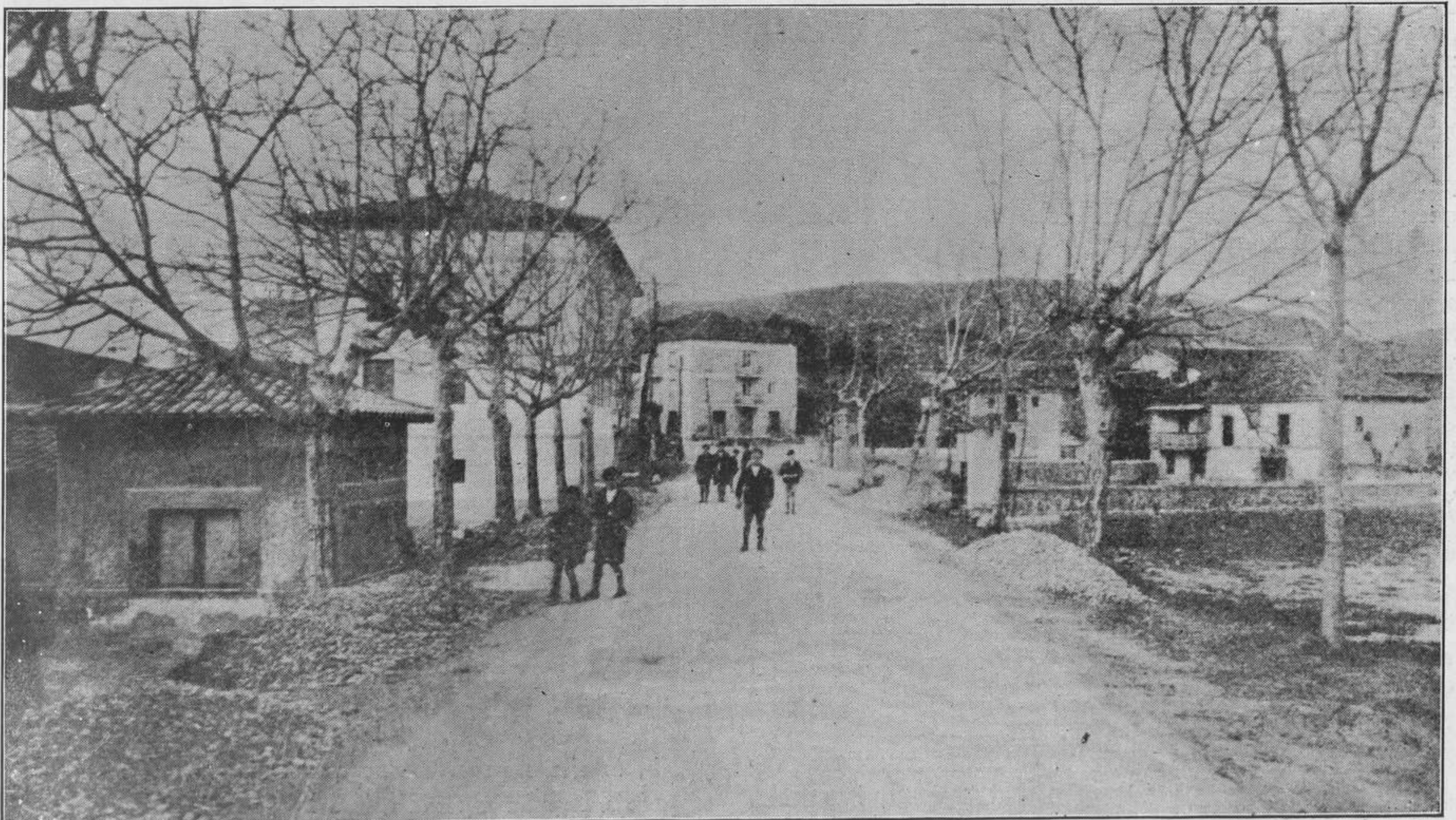
GAMA. — Entrada al pintoresco pueblo, por la carretera general de Bilbao.
