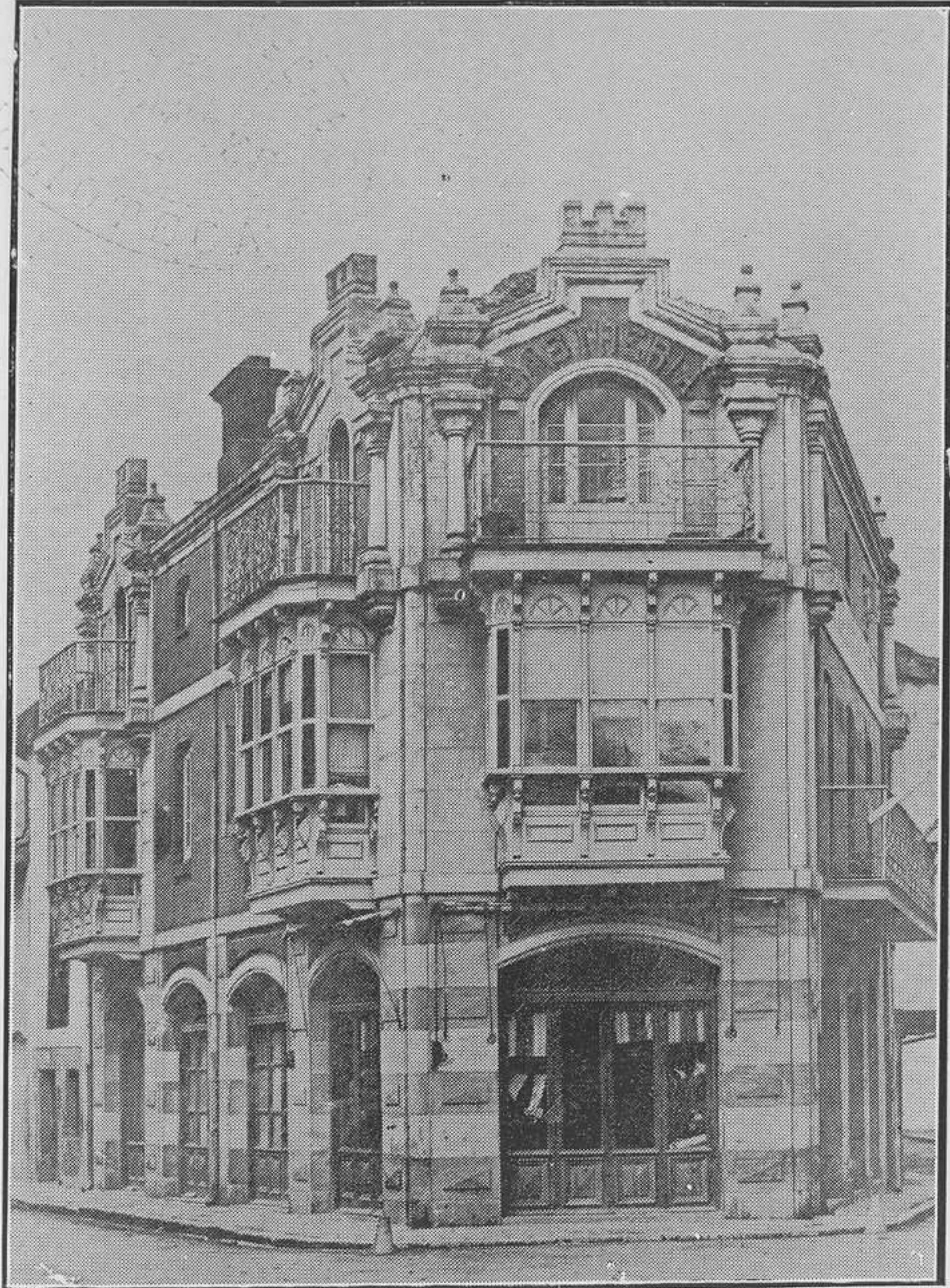
AMPUERO. —Vista de la casa Echeverría, en el barrio de la Plazoleta.
