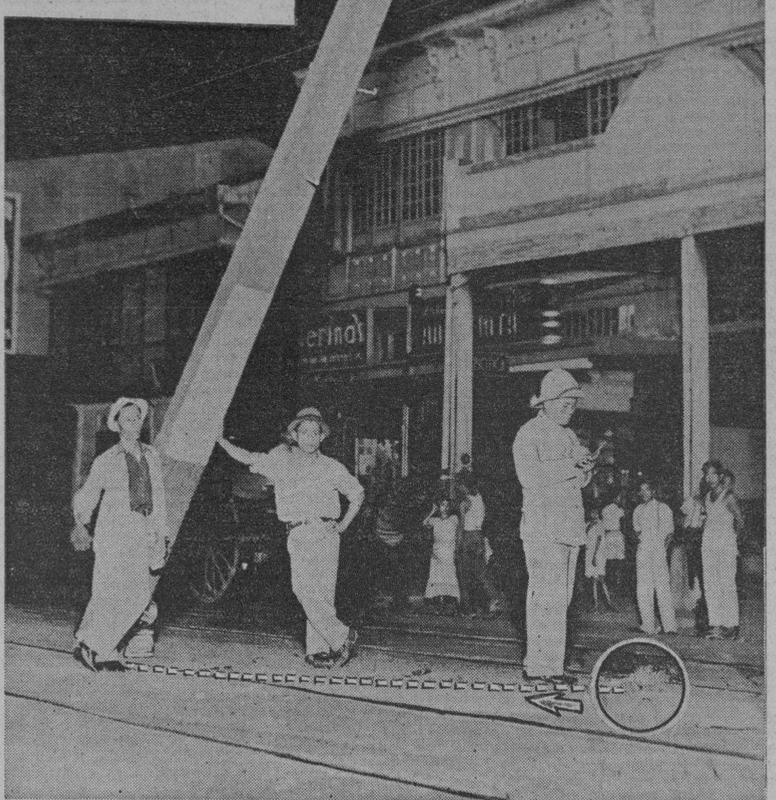
El estado de conservación de los postes de la Meralco que sostienen alambres electricos para tranvias y luces debe ser pobre cuando un automovil que lo choca consigue removerlo hasta una distancia de tres metros del sitio en que estaba plantado. Esto ocurrió anoche y causó estupefacción entre los residentes de la Avenida Rizal, esquina Camarines y Tayabas, cuando vieron que con un ligero empujon de un automovil un poste corre hasta tres
