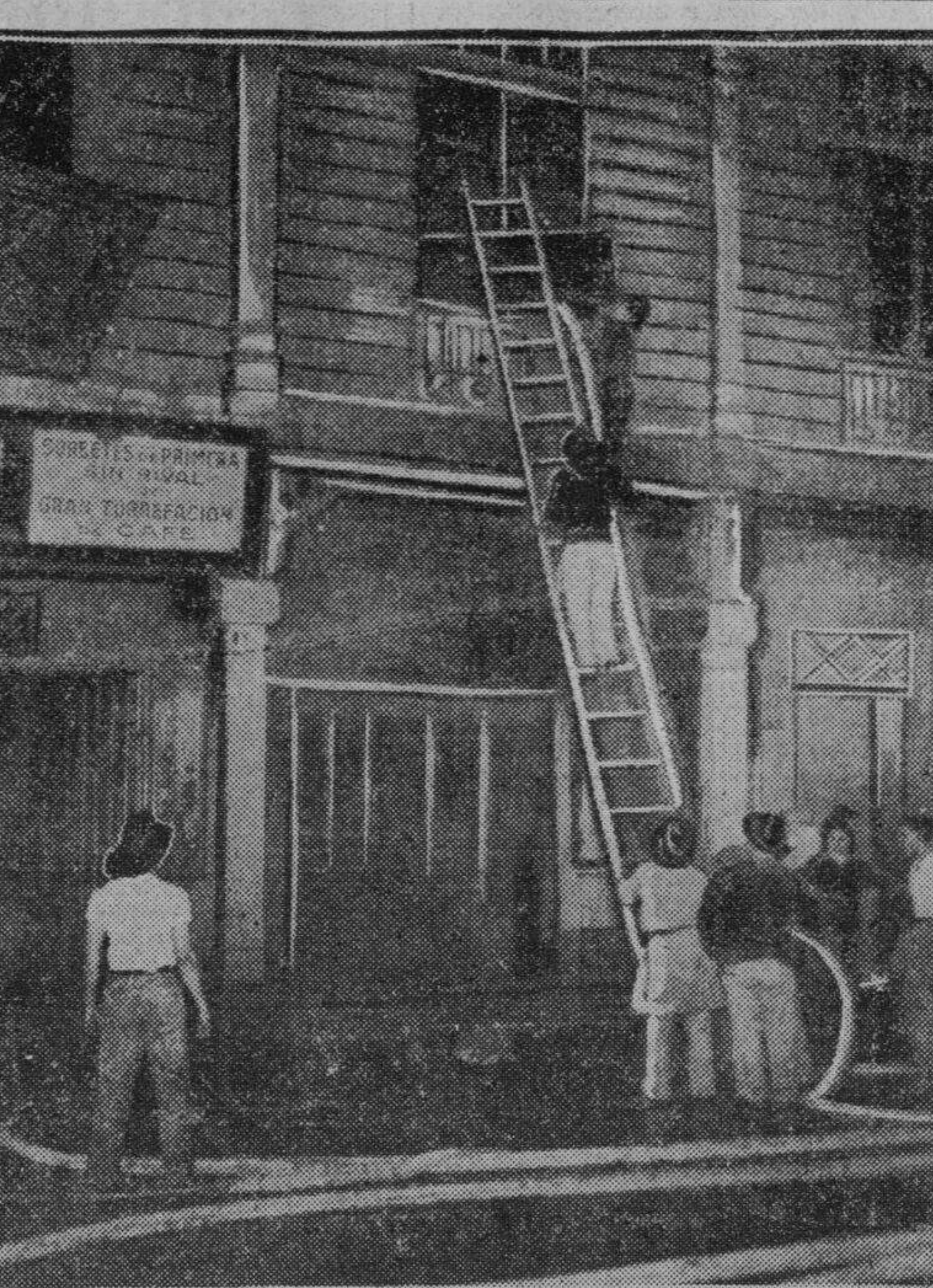
Fotografía tomada durante los trabajos de extinción del incendio de origen sospechoso según la policía, que partió del establecimiento Vanity Shop en la calle Carriedo, y que puso en peligro de ser destruido totalmente el edificio ocupado por el Restaurant Bahawaw, que fue un tiempo la oficina y talleres de los periódicos de la organización TVT. La fotografía presenta a los bomberos mientras tendían una escalera para llegar hasta los altos del edificio en llamas.
