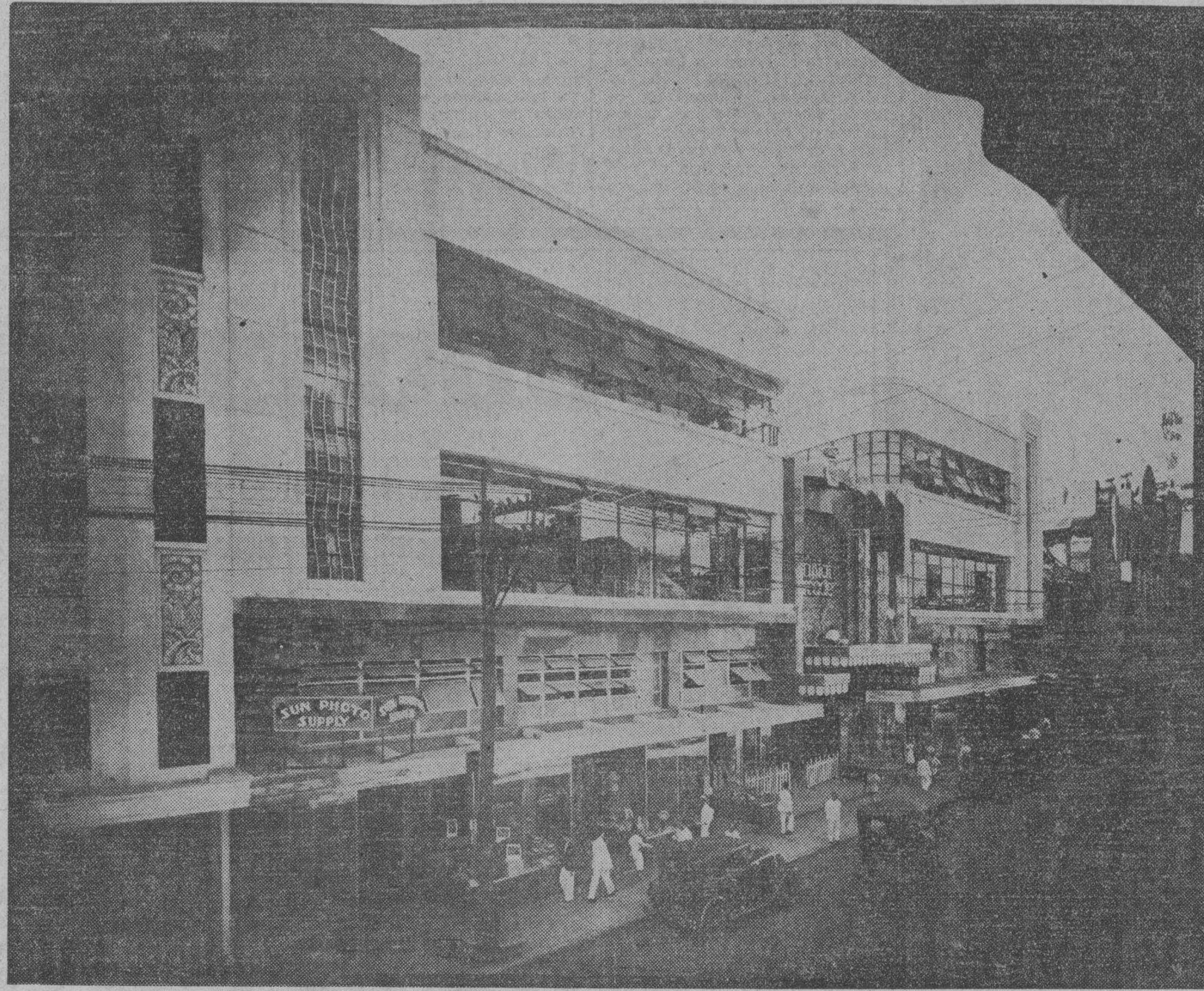
El Palacio de Cristal el único de su clase en el Oriente tal como a parece después de terminada su construcción. Con este nuevo edificio la colección de joyas arquitectónicas de Filipinas se ha visto aumentada con una más.
