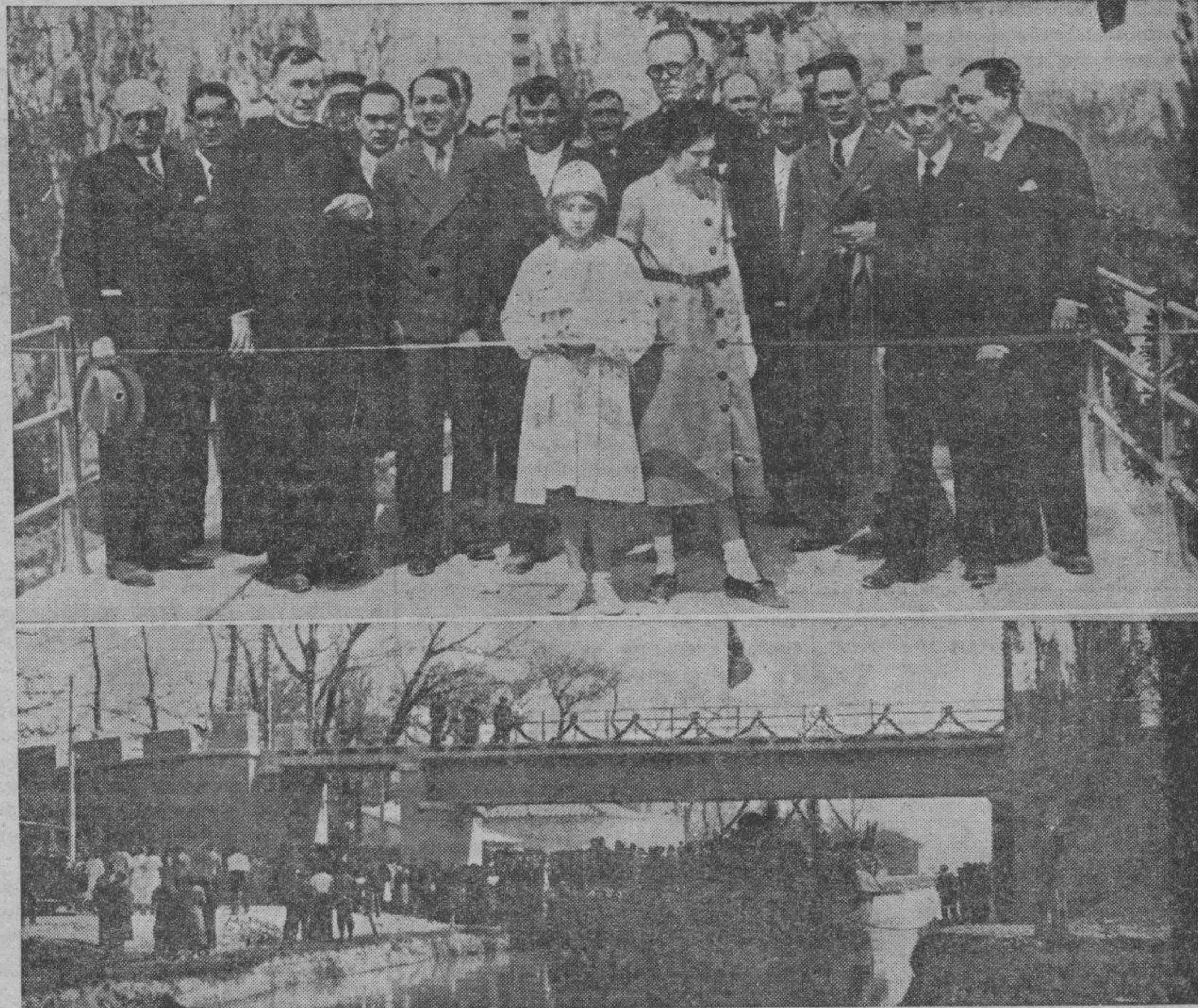
La encantadora niña María Pinilla en el instante en que cortó la cinta dando oficialidad al paso en el puente sobre el Canal, en Garrapinillos.— El novísimo puente.
