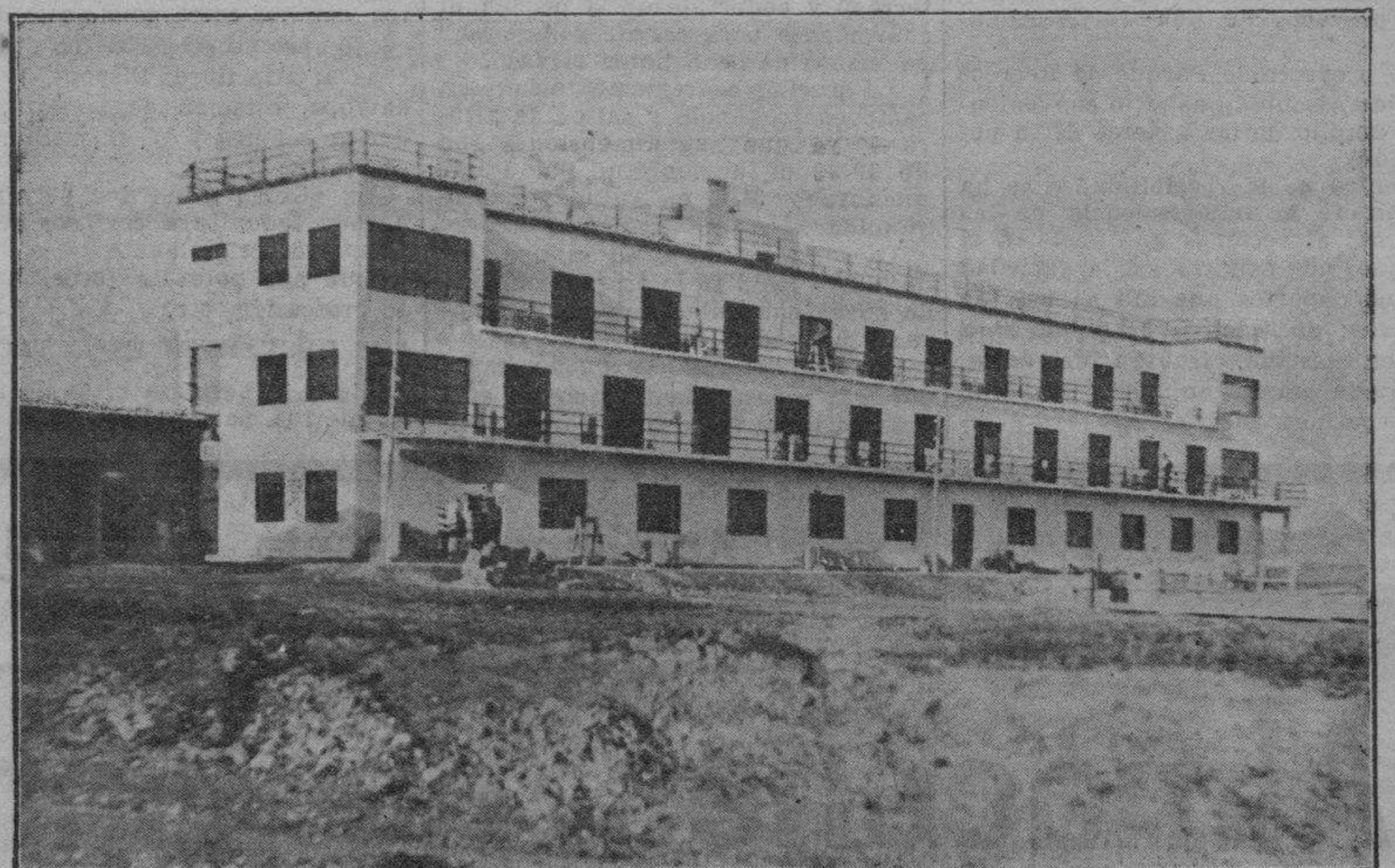
Pabellón de enfermos tuberculosos, que próximamente será inaugurado, de la Excm. Diputación de Huesca. Se ha ejecutado bajo la dirección del arquitecto provincial don José Beltrán Navarro, y de conformidad con el proyecto redactado por el que fué arquitecto provincial don José Luis de León, siendo contratista el industrial de esta localidad don Bernardino Oliván Sanagustín.
