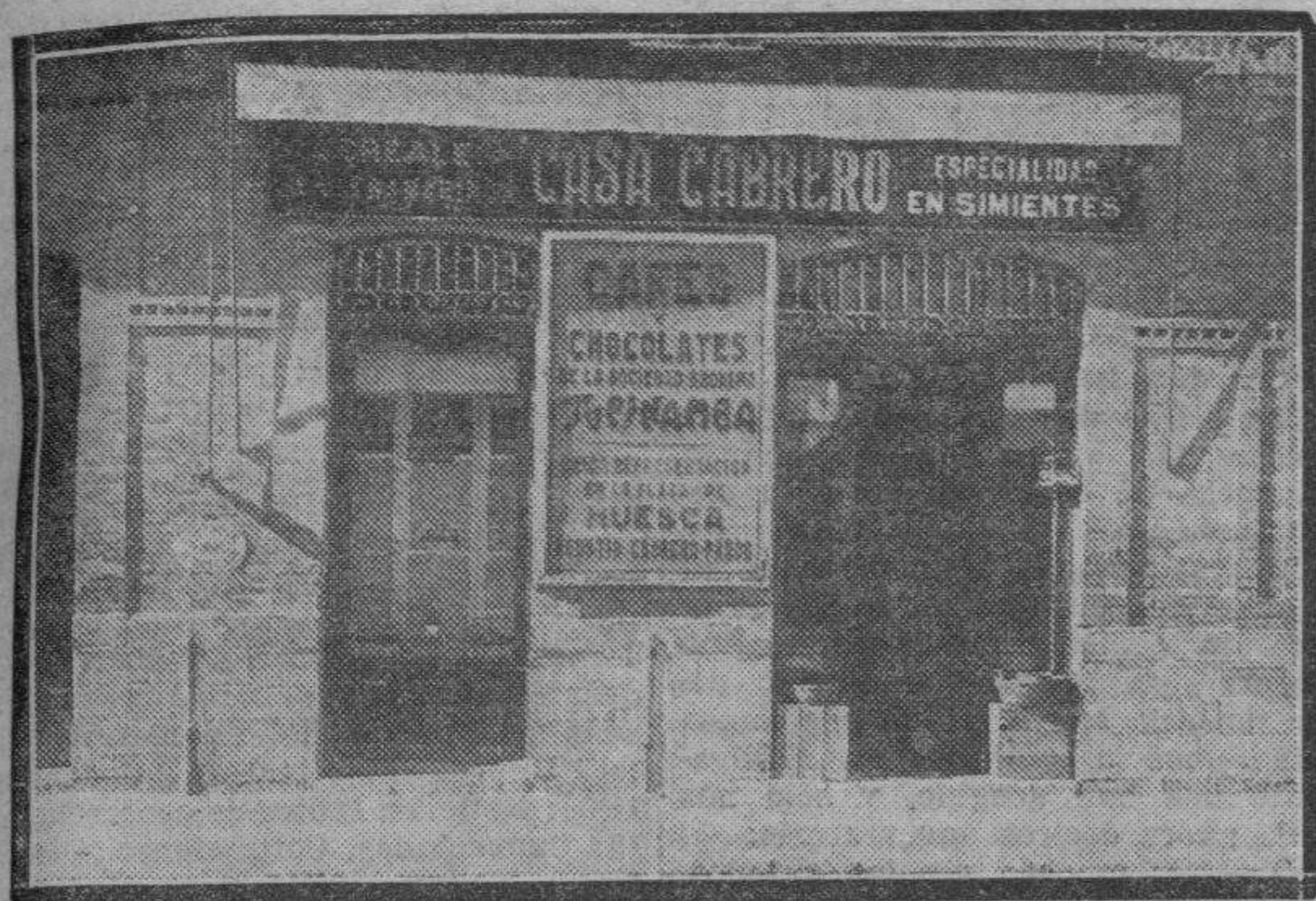
Fachada del establecimiento.
