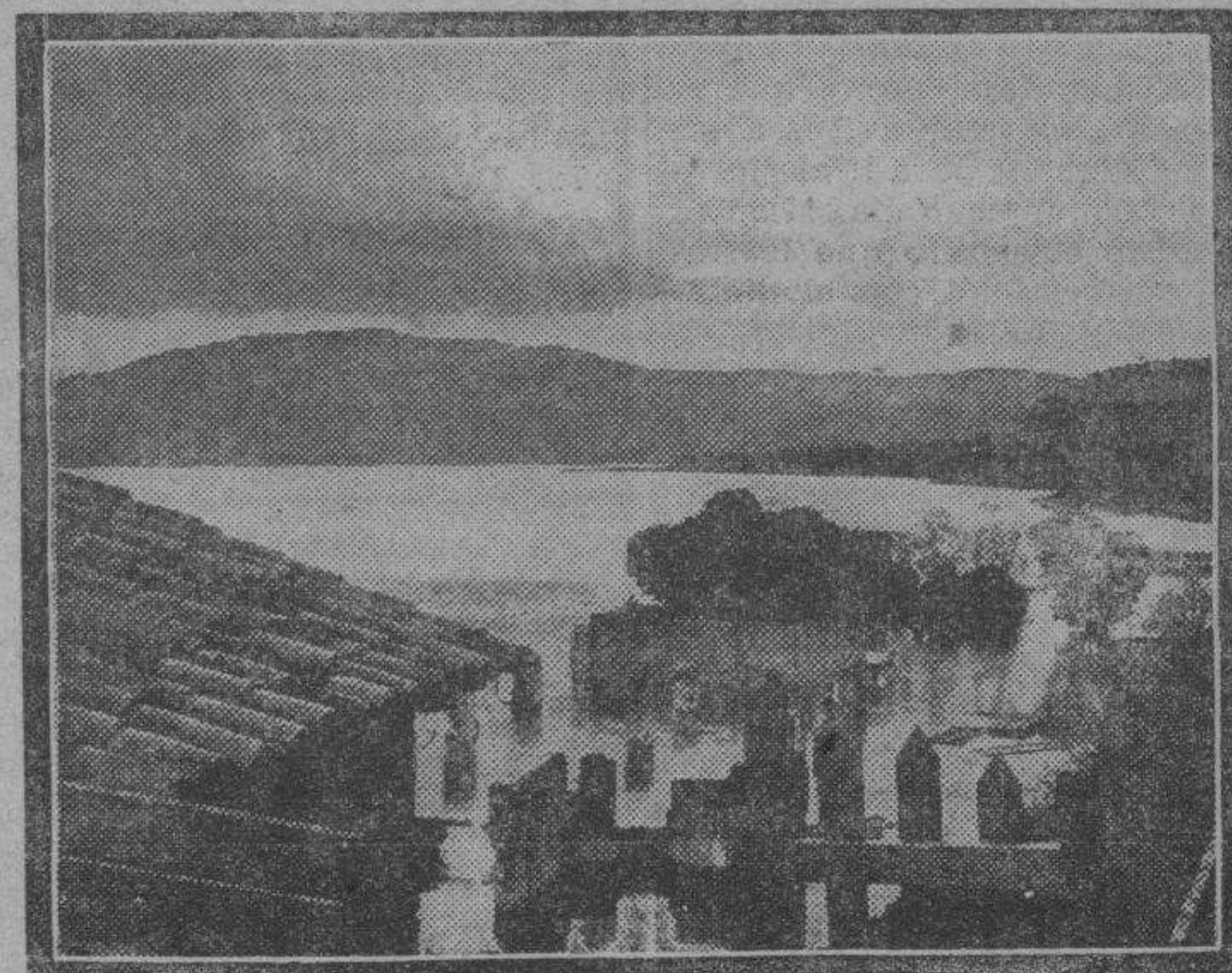
GRAUS. — Pantano de Barasona. Punto de la presa en el fondo, al centro. A la izquierda: Emplazamiento del pueblo de Barasona, del que todavía se divisa la veleta de la torre (en la fotografía se divisa un punto). En primer término, lo que fué casa-habitación del señor gerente de la fábrica de aserrar maderas, llamada Resordí.
