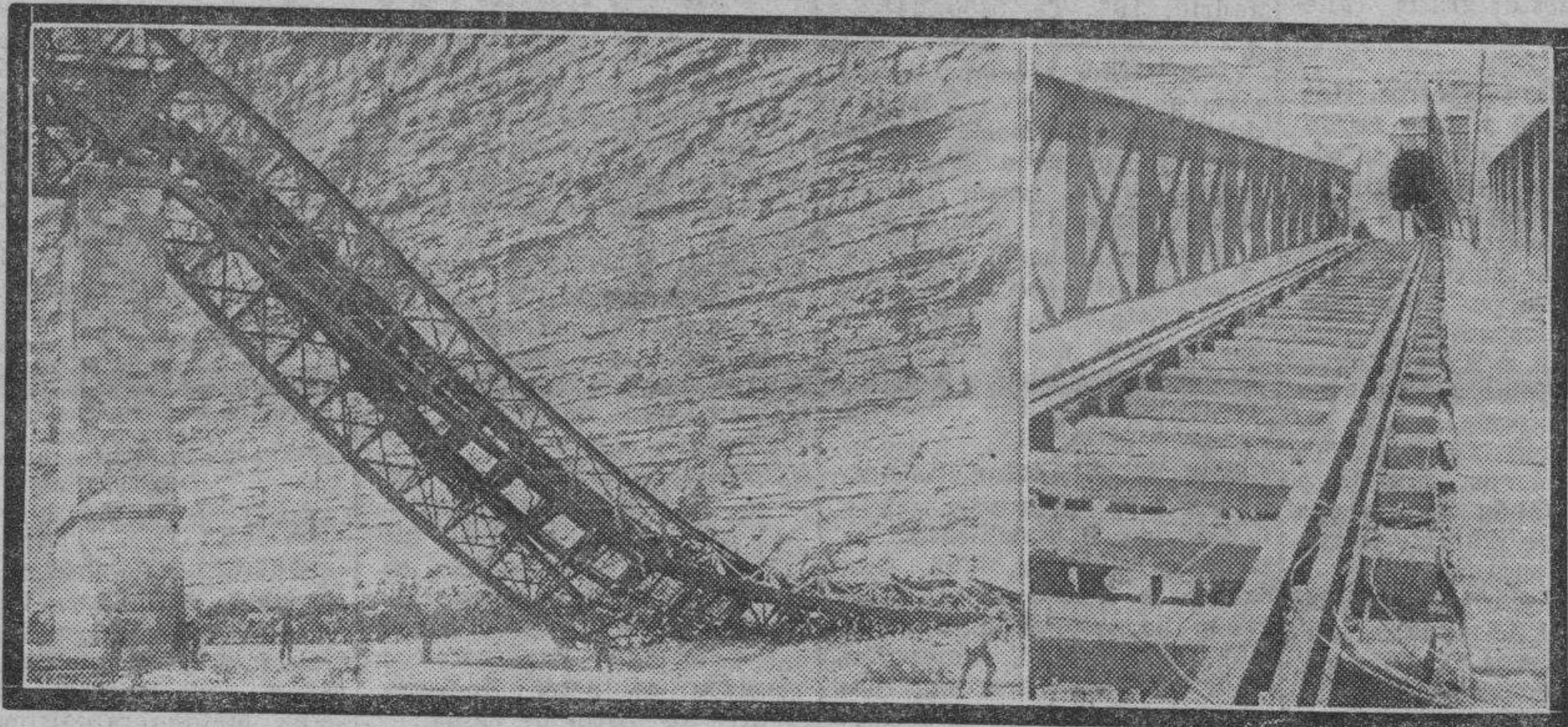
A la derecha: Un aspecto de las obras que se realizan para normalizar cuanto antes el servicio de trenes. A la izquierda: Estado en que quedó el trozo de puente no derrumbado.
