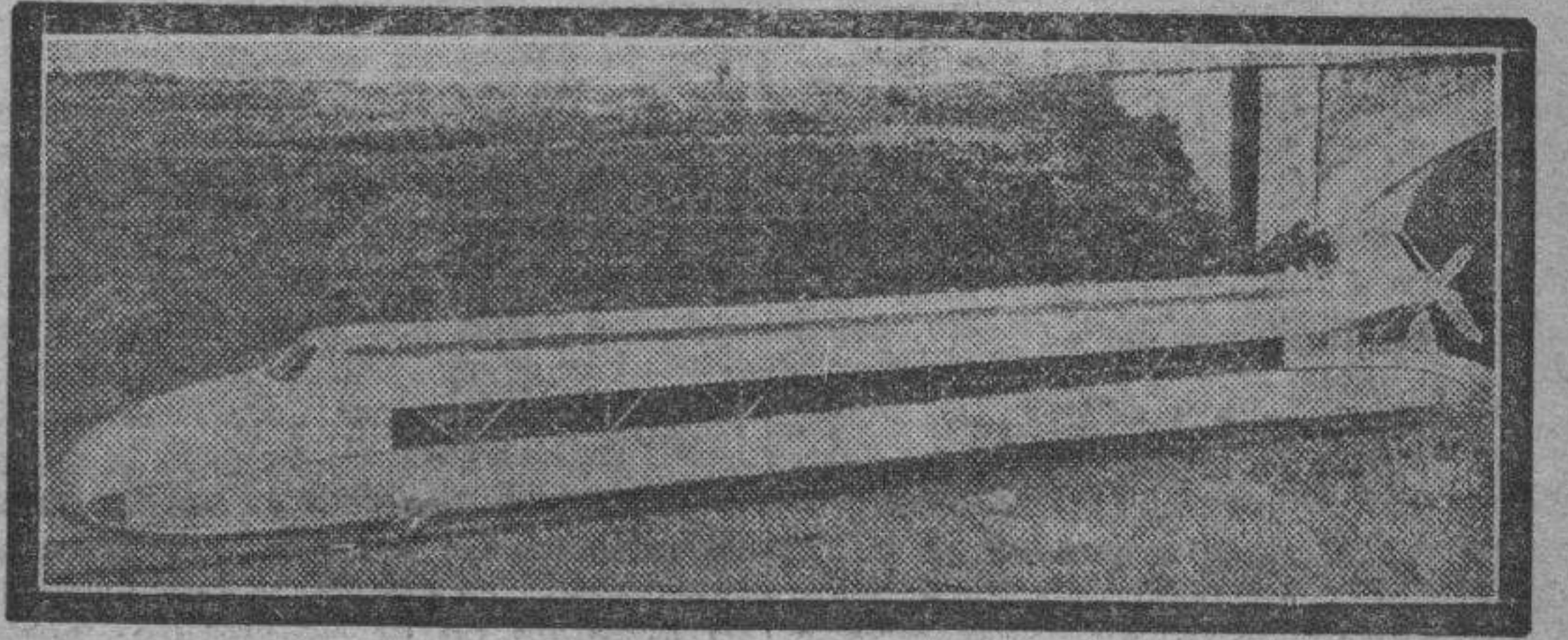
El moderno tren alemán mando a hélice, que ha sido objeto de detenidos ensayos y recientemente aprobado en Berlín, con el asombroso resultado de una media horaria de 180 kilómetros.
