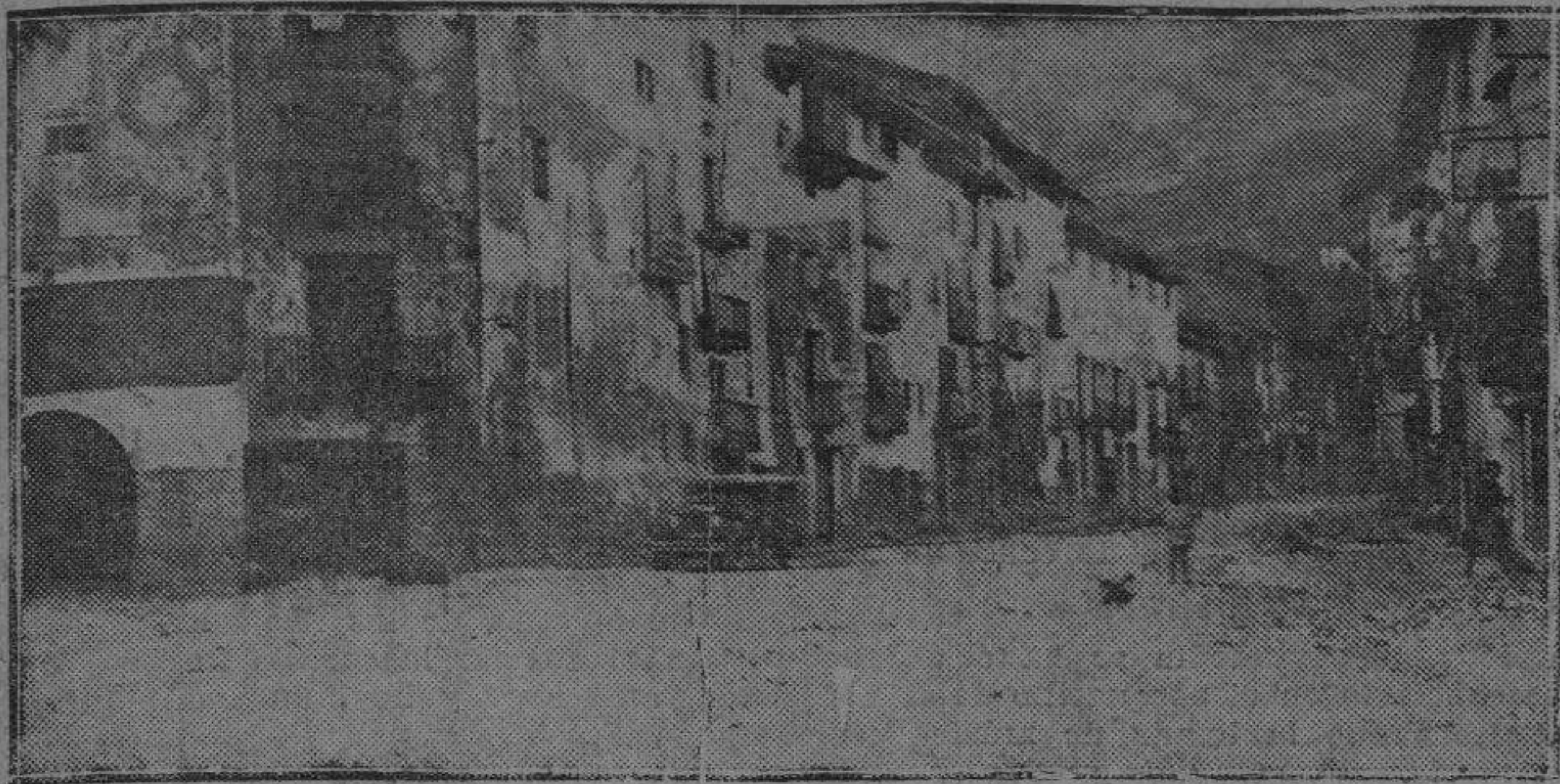
Entrada de la calle de Salamero, una de las afectadas por la importantísima mejora urbana
