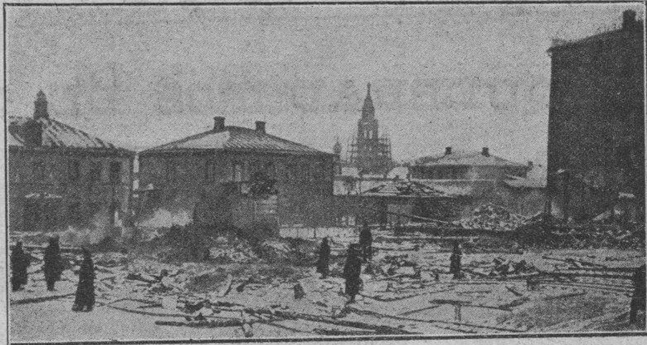
Dstrucción de la casa Gromof, en la calle Pikova.
