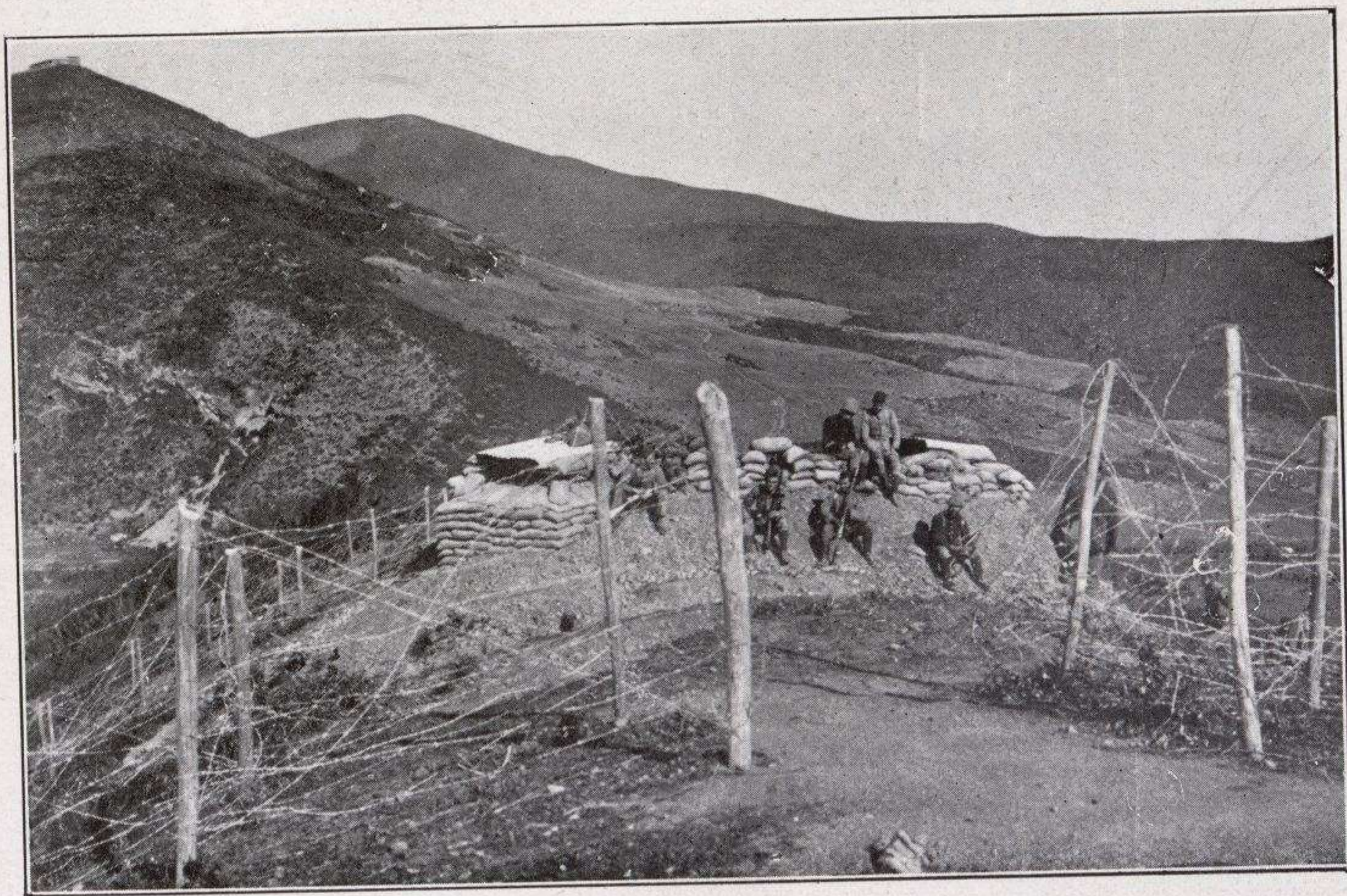
Vista general del blocaus de la posición avanzada de Monisla Sur (campo exterior de Ceuta). Fot. Rubio.
