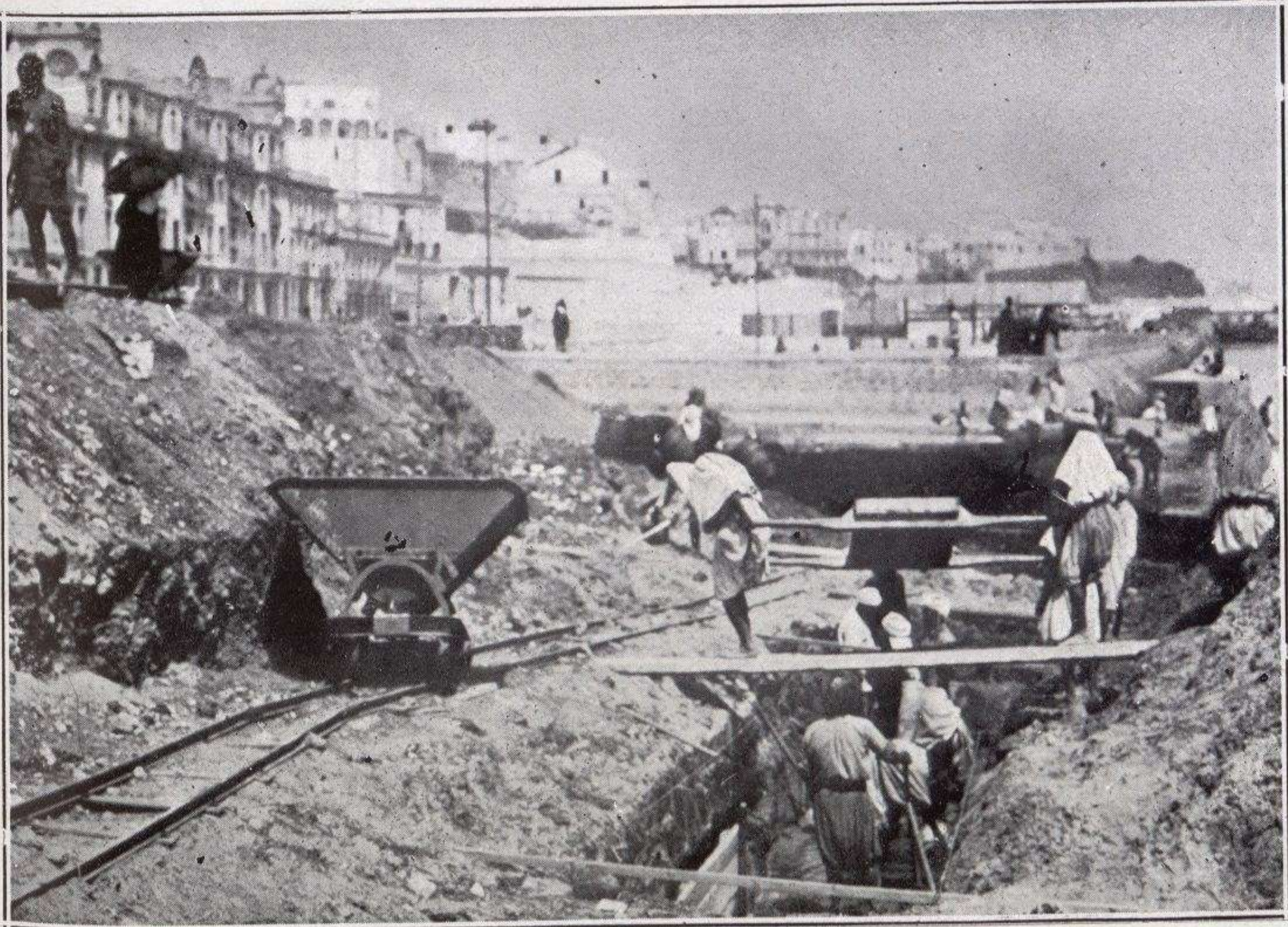
Tánger.—Trabajos para terraplenar los nuevos muelles del puerto
