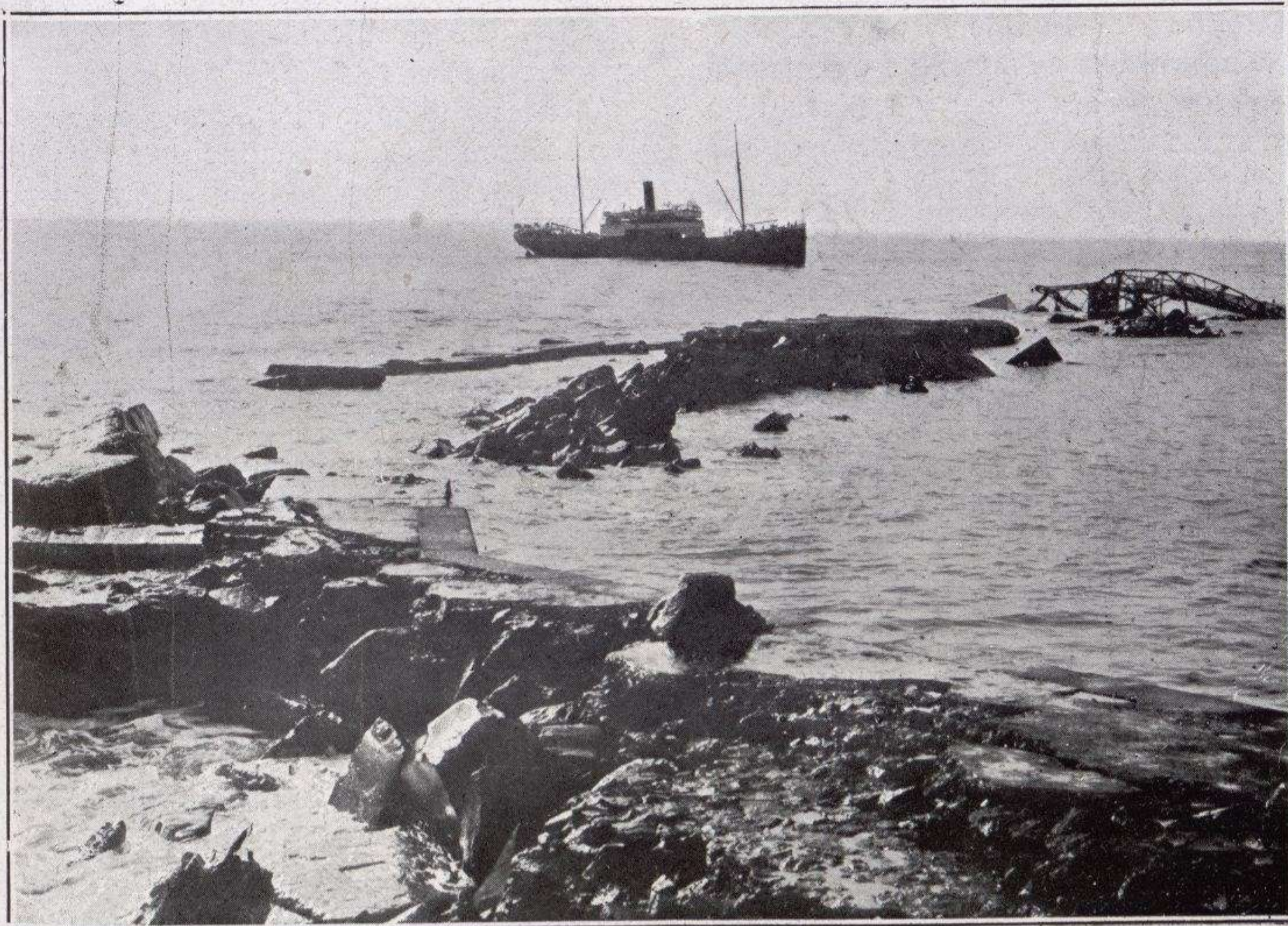
Melilla.—Vista de los restos del espigón del muelle y grúa «Titán» después del temporal.
