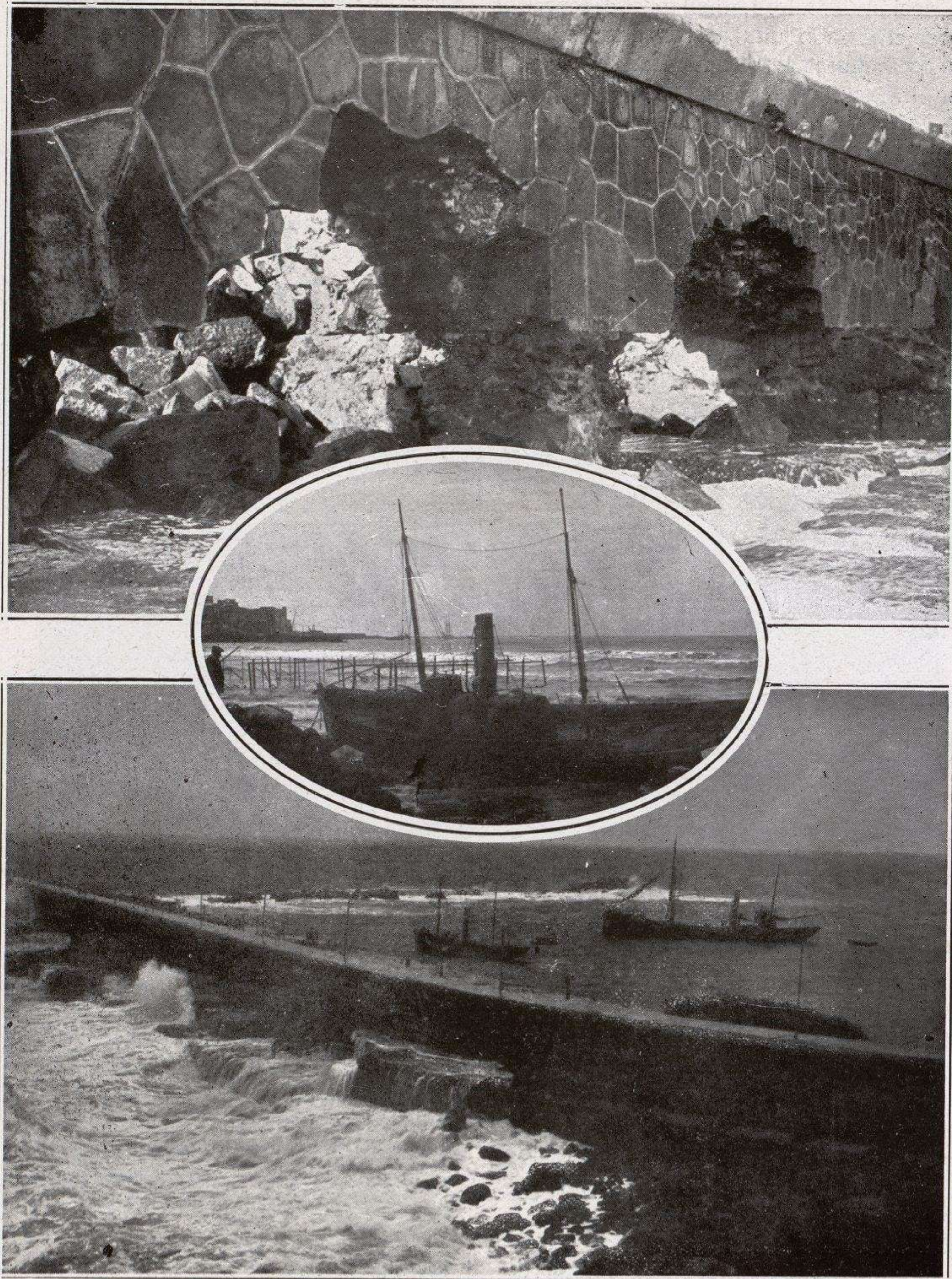
El espaldón del muelle horadado por dos partes que por su tamaño parecen ojos de puente. —El remolcador «Paulina» encallado en la playa de Trina, junto a los baños del recreo. —Vista del muelle destruído por el horroroso temporal. Fot. Silva.
