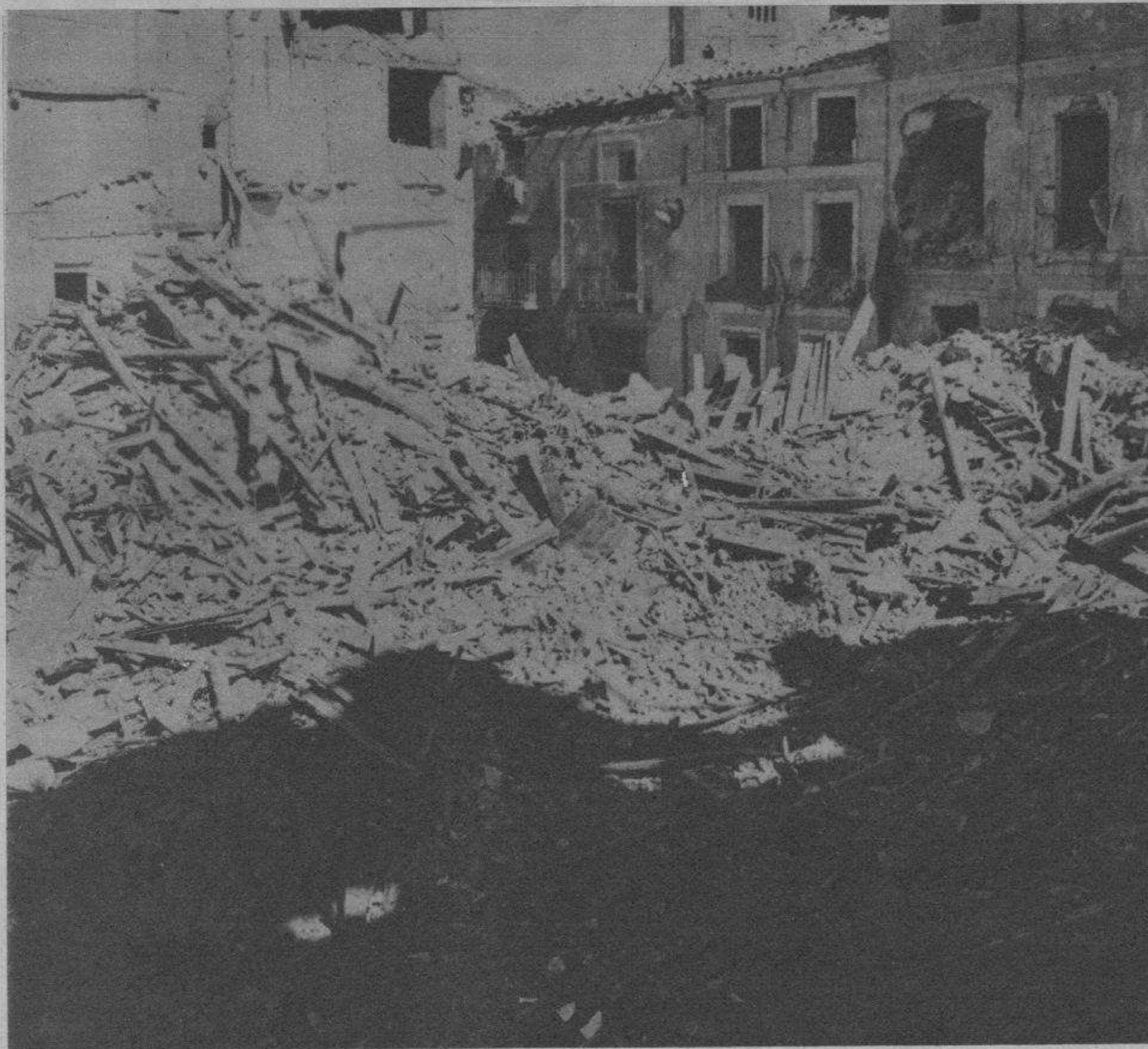
Sima producida por una mina, en el Banco de España.
