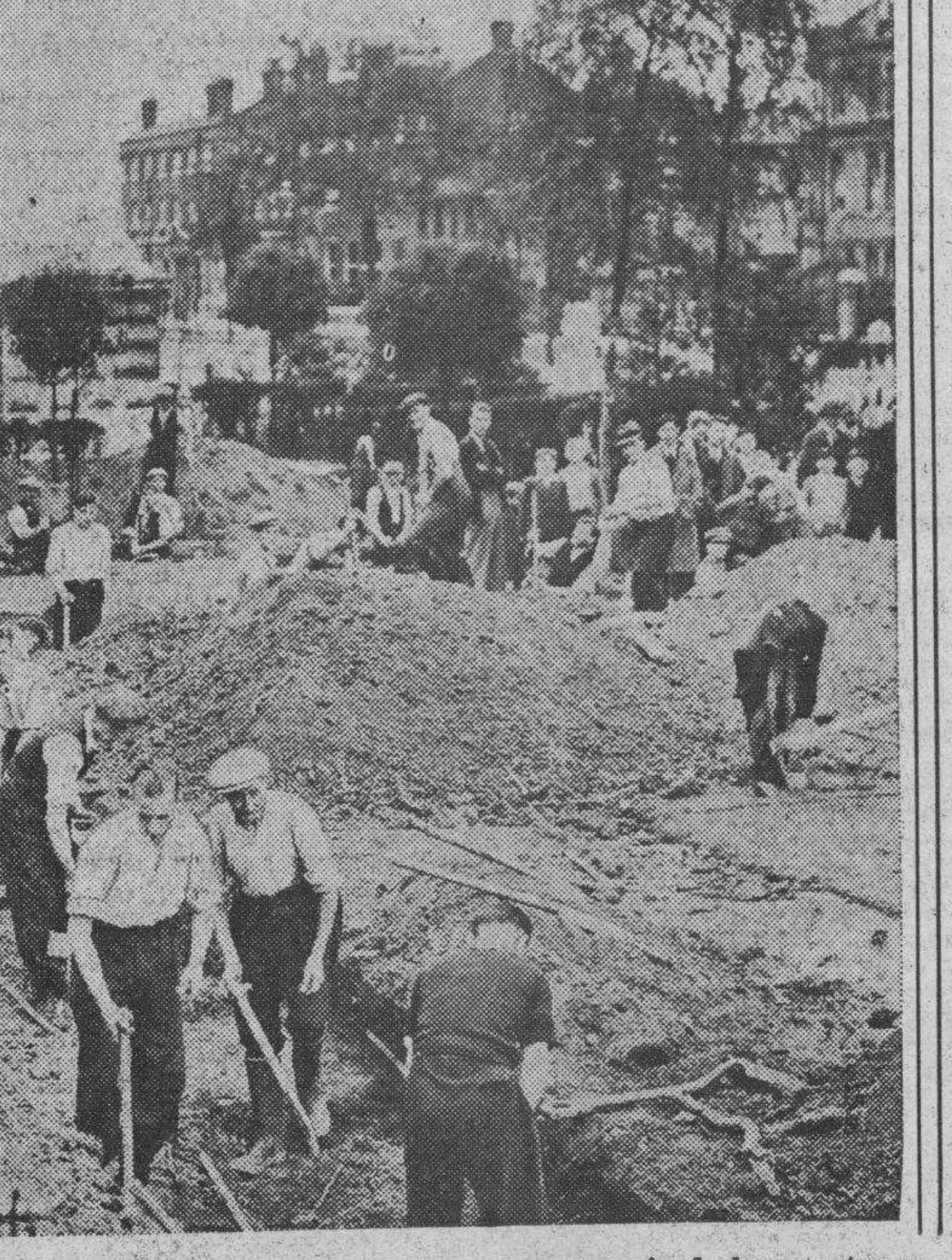
Justamente al frente del monumento Lewisohn, erigido por Inglaterra a la memoria de los muertos en la guerra de 1914, los obreros trabajan febrilmente excavando refugios contra bombas en previsión de la guerra que amenaza estallar. (Foto Acme-Editor Press).
