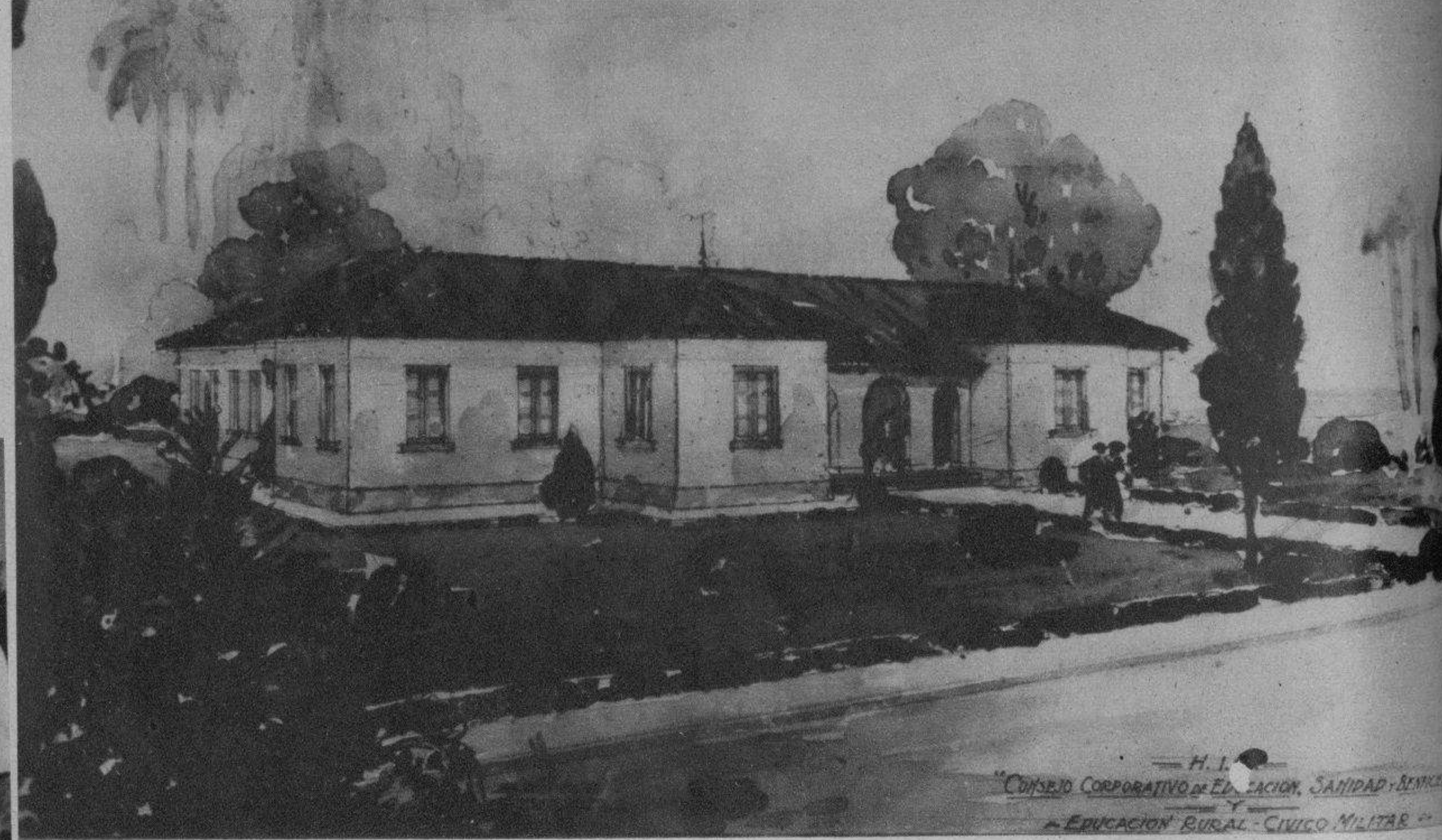
PROYECTO de fabricación del Hogar Campesino Infantil, en la Finca «La Jita», donde el Central Soledad ha cedido una caballería de tierra, en el Barrio de Guaos (Cienfuegos), trabajo que se realizará
