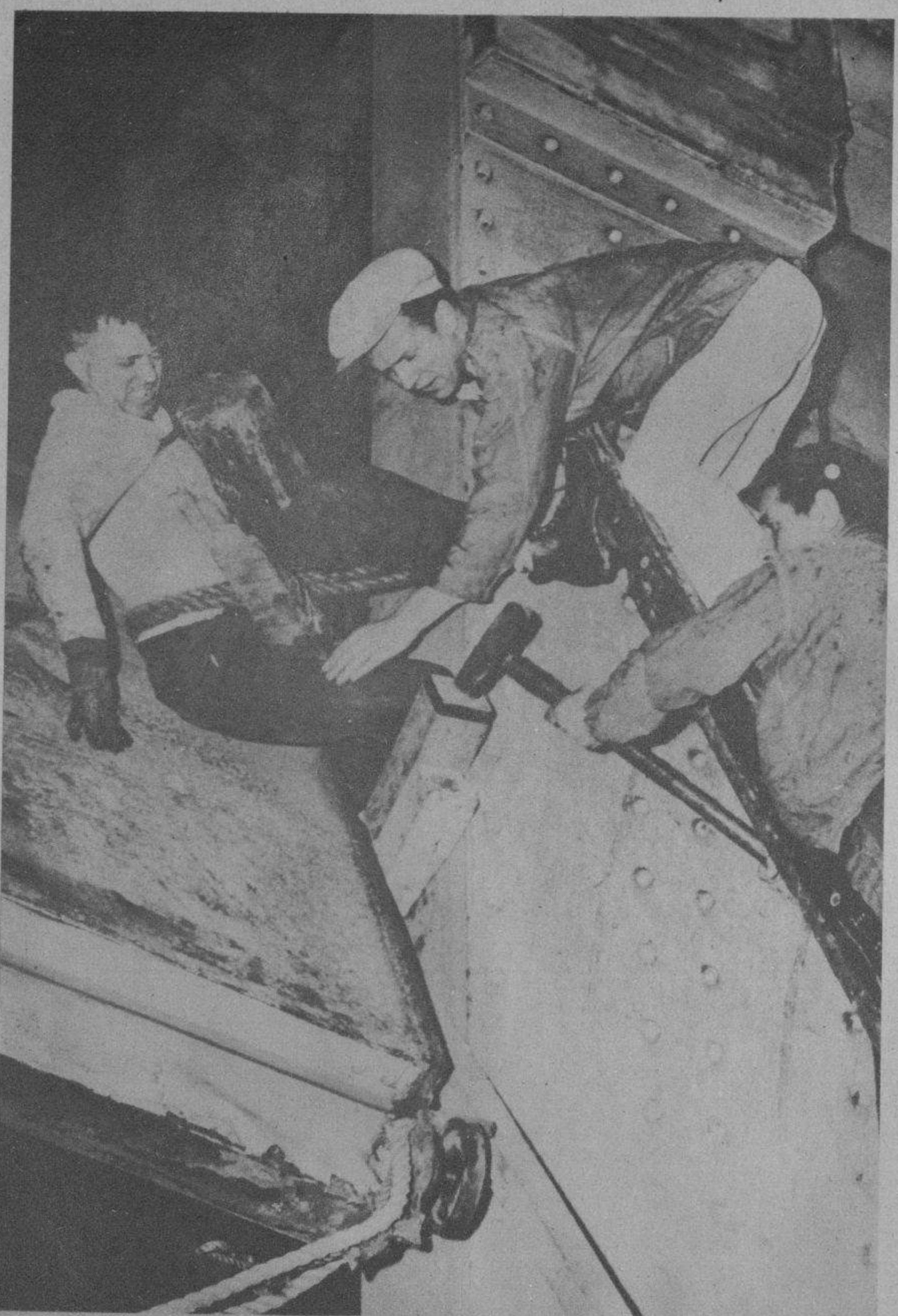
FRANK J. DOWNES, electricista de la base militar de Boston, estuvo durante media hora comprimido entre dos pedazos de acero con peso de dos toneladas: las puertas del muelle donde trabajaba. La pierna derecha le quedó fracturada. Aquí se ven los esfuerzos de dos de sus compañeros, ayudándole a libertarse (Foto Wide)
